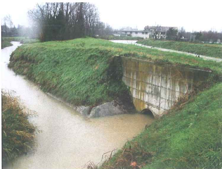
Figura 10- Scarico della botte a sifone e collettore Bazzera (11 dicembre 2008)
