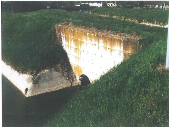
Figura 8- Scarico della botte a sifone nel collettore Bazzera (foto del 20 marzo 2009)
