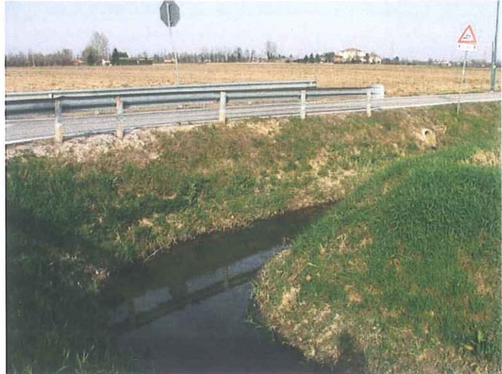
Figura 17- Collettore Tarù all'incrocio fra via Ponte Nuovo e via Tarù
