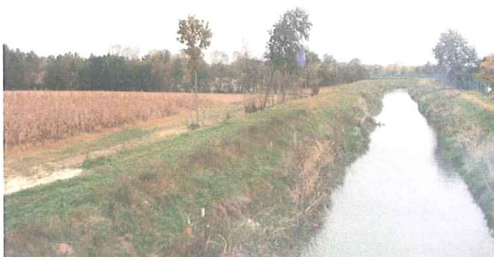
Figura 28- Fiume Dese nei pressi del ponte sul Passante
