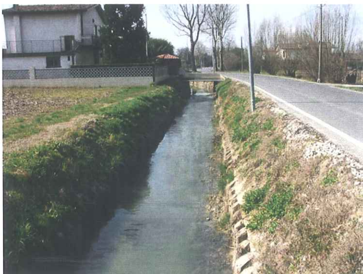
Figura 14- Collettore Bazzera su via Morosini in corrispondenza della galleria in progetto
