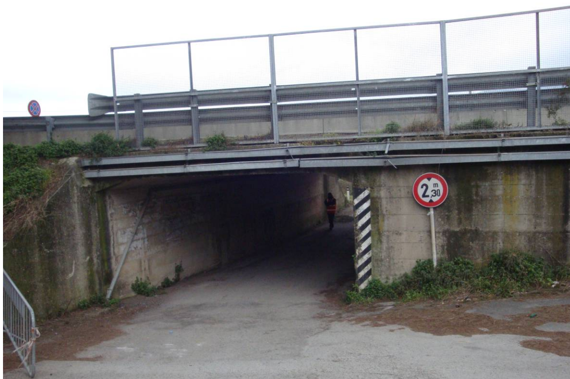
Foto 2 – Vista laterale da est
