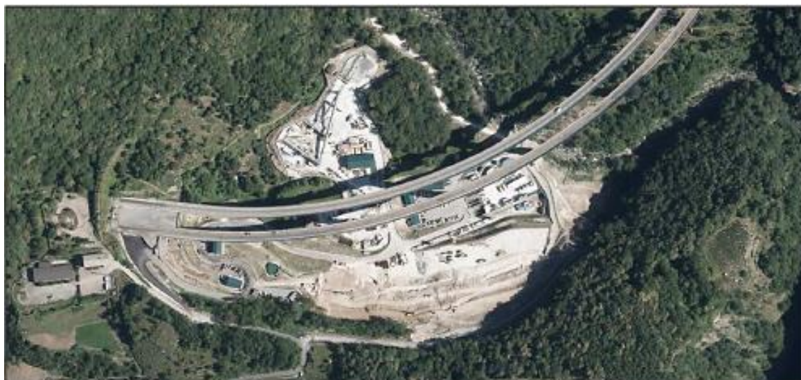
Figura 3 – Vista aerea del cantiere di Chiomonte (Fonte : TELT, presentazione Torino 8 Aprile 2015)
