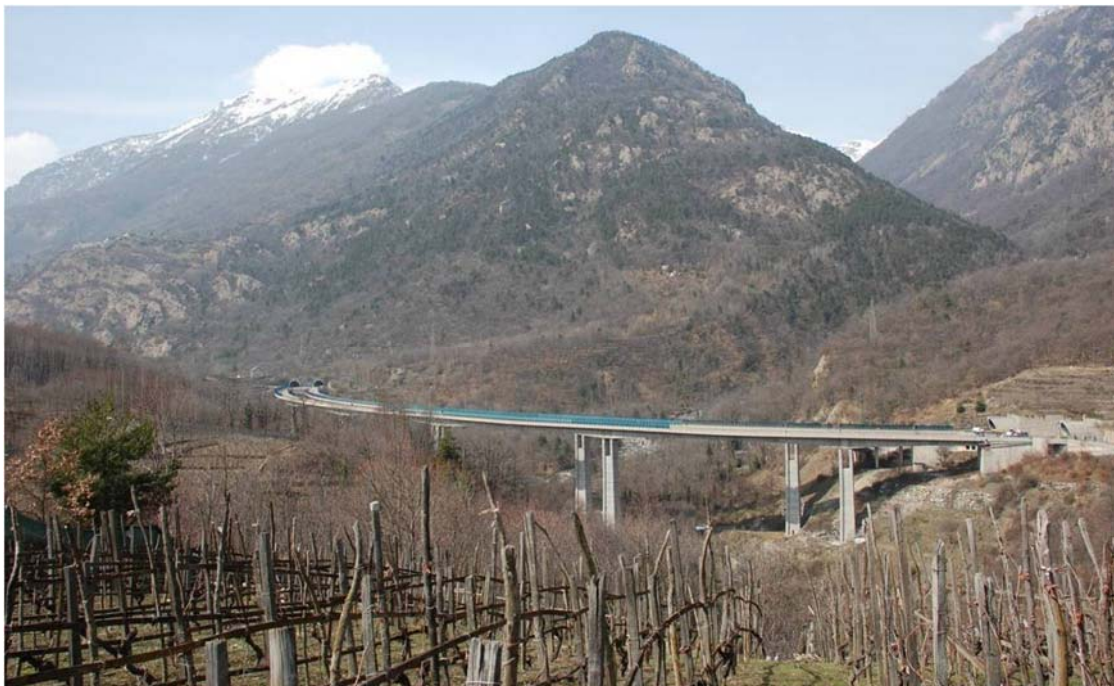
Figura 12 – Il viadotto Clarea e la Val Clarea – vista ante installazione del cantiere del cunicolo dai vigneti posti a sud-est dell’area di intervento
