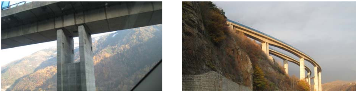
Figura 11 – Viste dell'infrastruttura esistente – dettaglio impalcato e viste d'insieme
