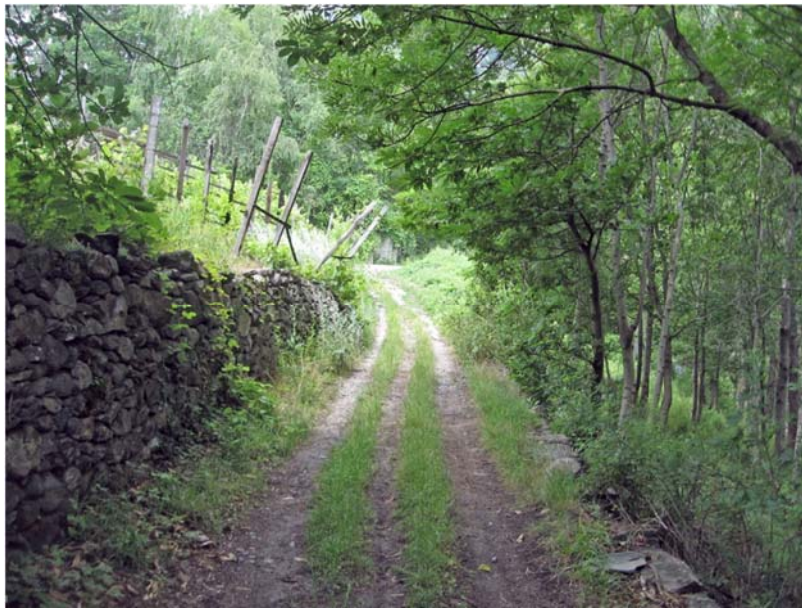
Figura 6 – Fotografia di un muretto a secco tipico del versante
