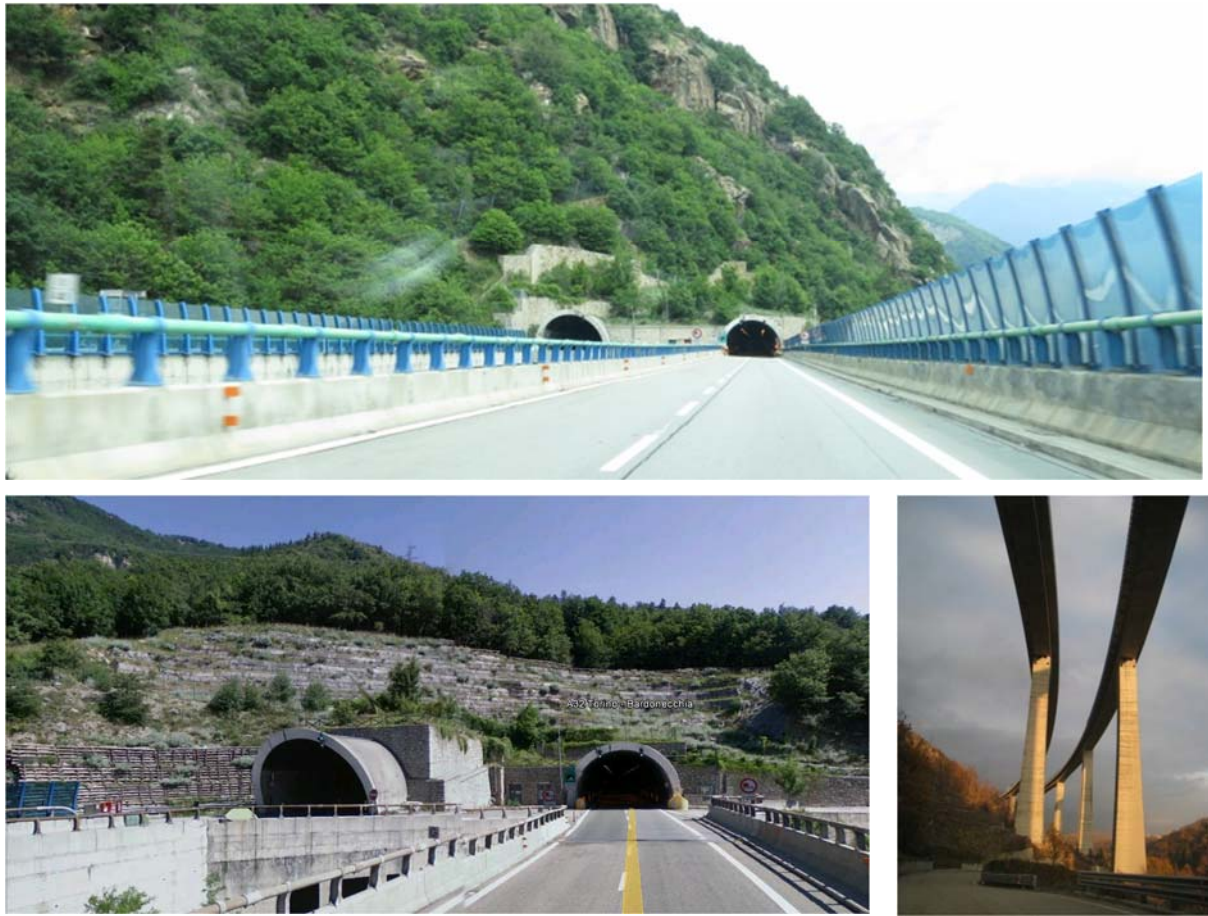
Figura 9 – Viste dell’infrastruttura esistente – imbocchi galleria e viadotto visto dal basso
