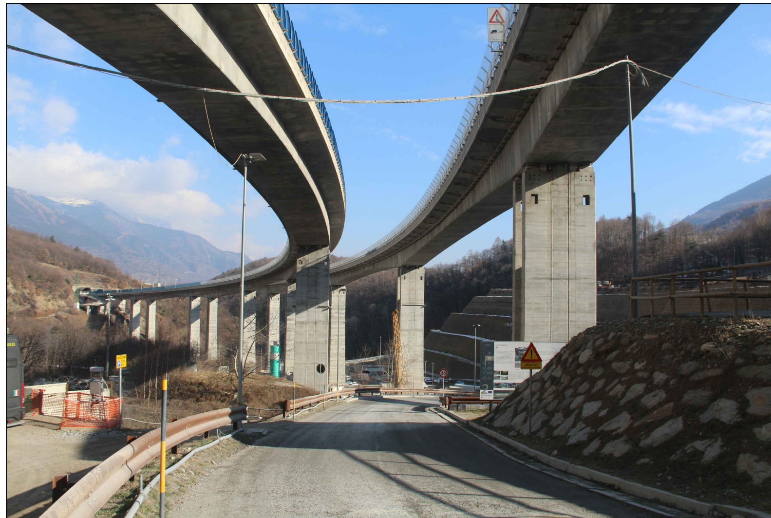
Foto 4: Vista del viadotto Clarea da Via Dell'Avanà
