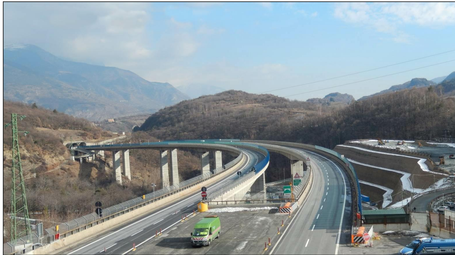
RIPRESA FOTOGRAFICA B - Stato di fatto
