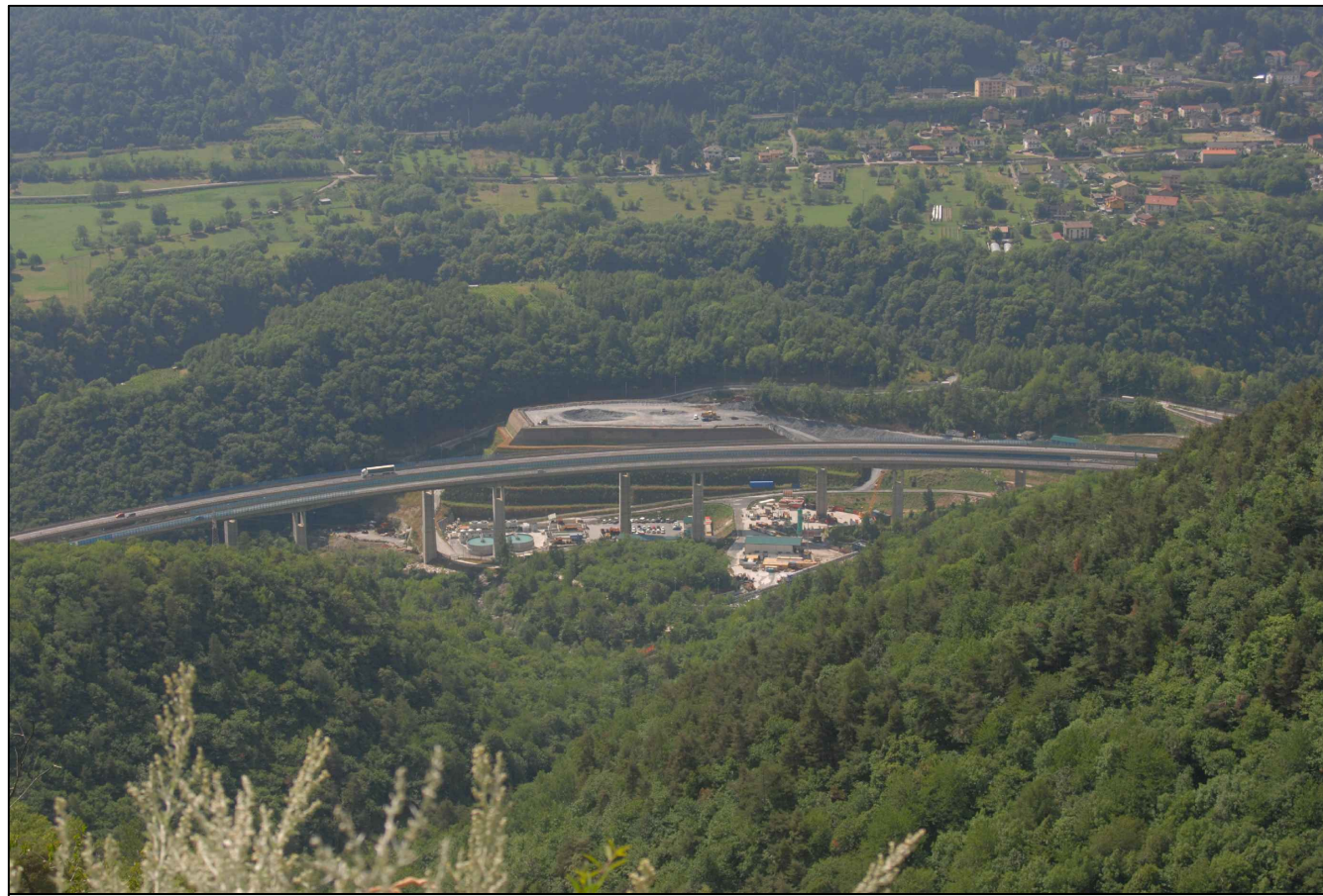
Foto 5: Vista del Viadotto Clarea dalla SP 255 della Val Clarea
