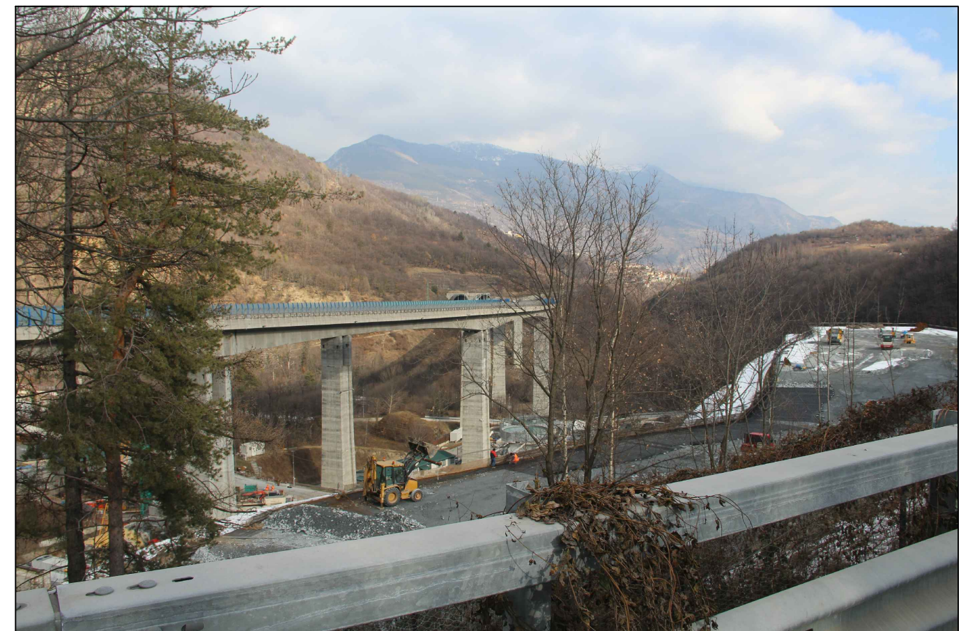
Foto 3a: Vista da Via Dell'Avanà
