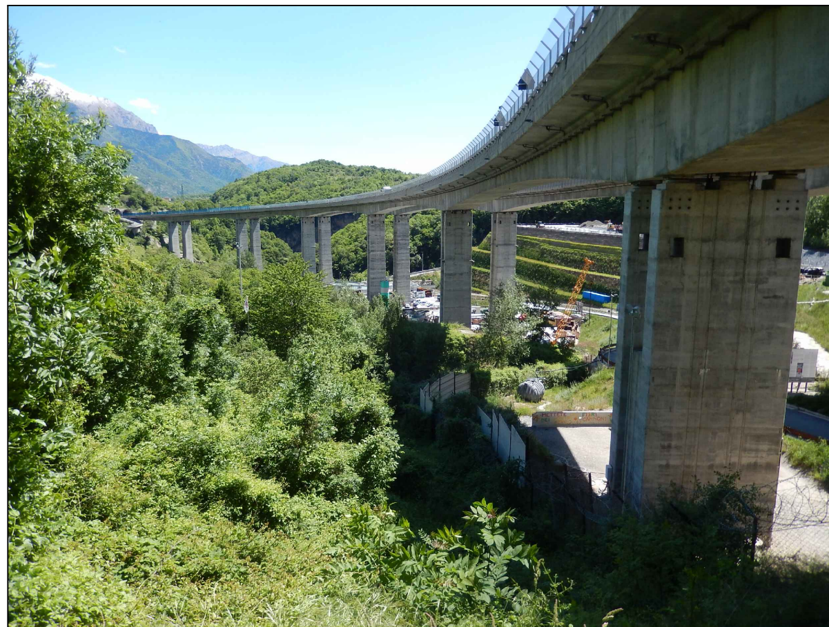
Foto 13: Vista del viadotto lato Nord
