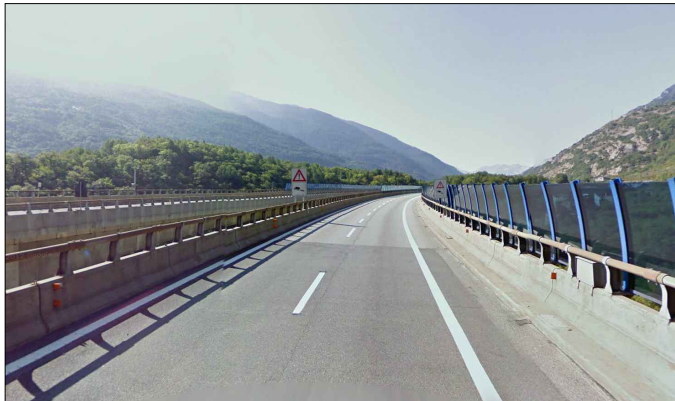
Foto 2: Vista dal viadotto autostradale esistente, direzione Bardonecchia (fonte: Street View)
