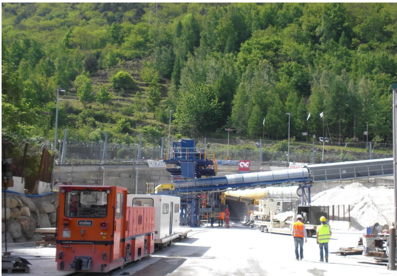
Barriere in reti paramassi presenti a monte dell'imbocco della galleria del cunicolo della Maddalena.
