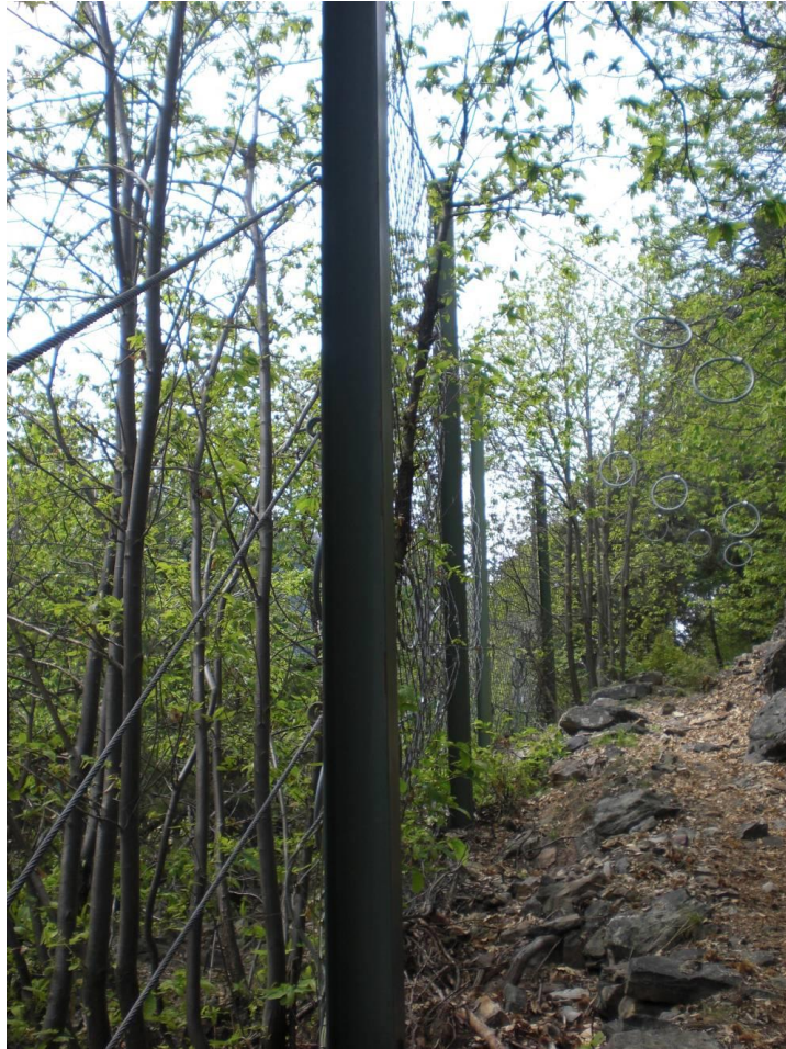
Dettaglio delle barriere paramassi presenti lungo il versante
