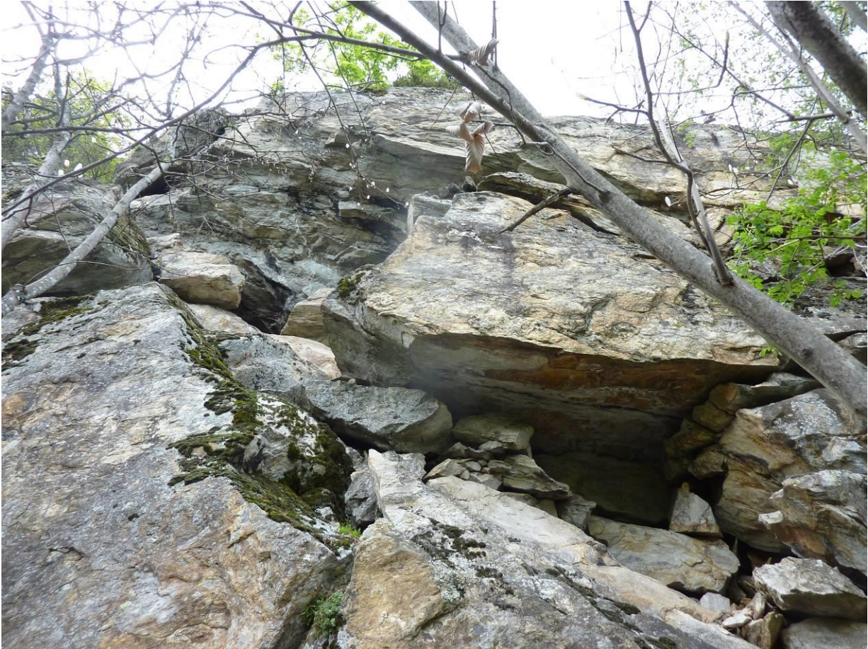
Esempio di massi potenzialmente instabili per fenomeni di crollo.
