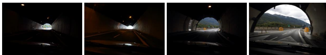
Fig. 2 – Avvicinamento alla sezione di uscita della galleria Giaglione dx.
