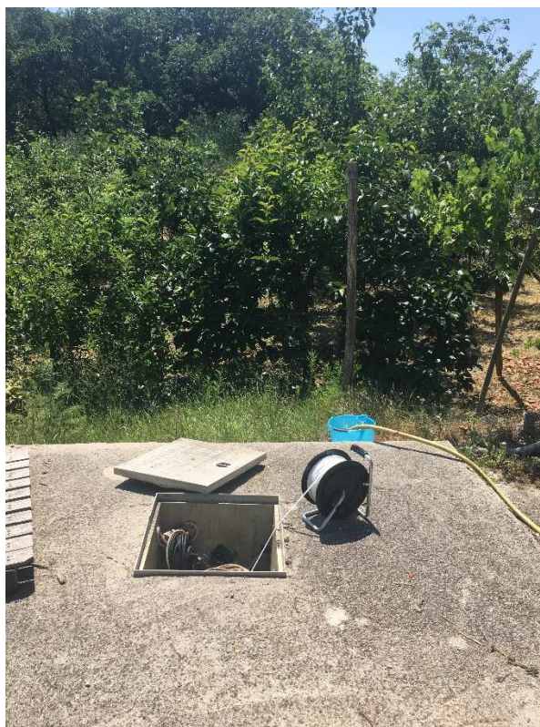
Fig. 1 Fase di allestimento prova di emungimento
