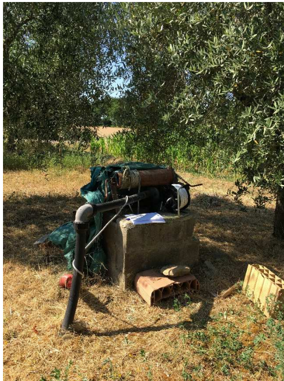
Fig. 1 Fase di allestimento prova di emungimento
