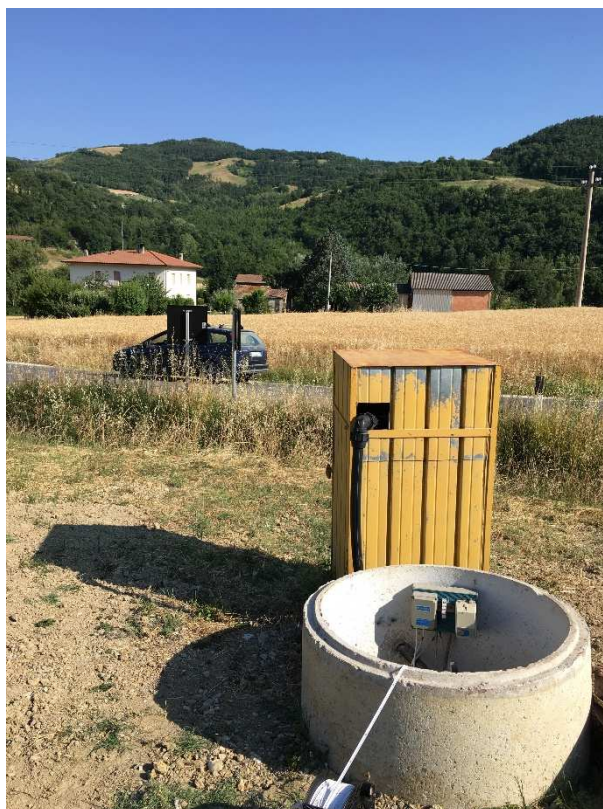
Fig. 1 Fase di allestimento prova di emungimento
