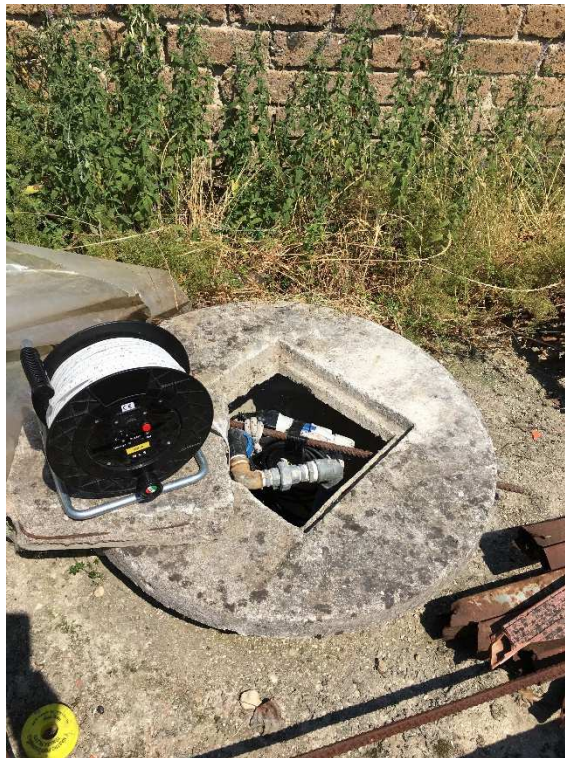
Fig. 1 Fase di allestimento prova di emungimento
