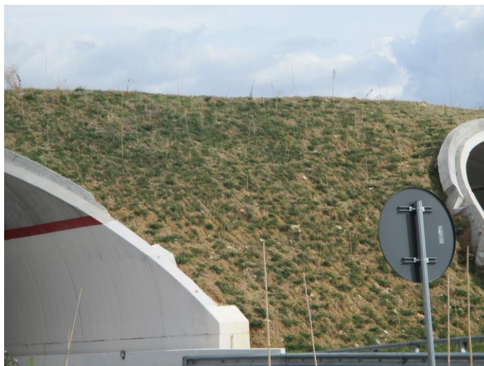
Esempi di sistemazione degli imbocchi in galleria
