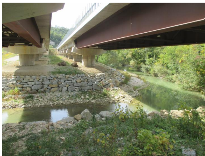
Esempi di sistemazione di area sottoviadotto
