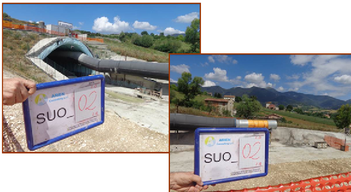
Stazione di campionamento SUO_02 Area di cantiere per lo scavo galleria "Le Serre"
