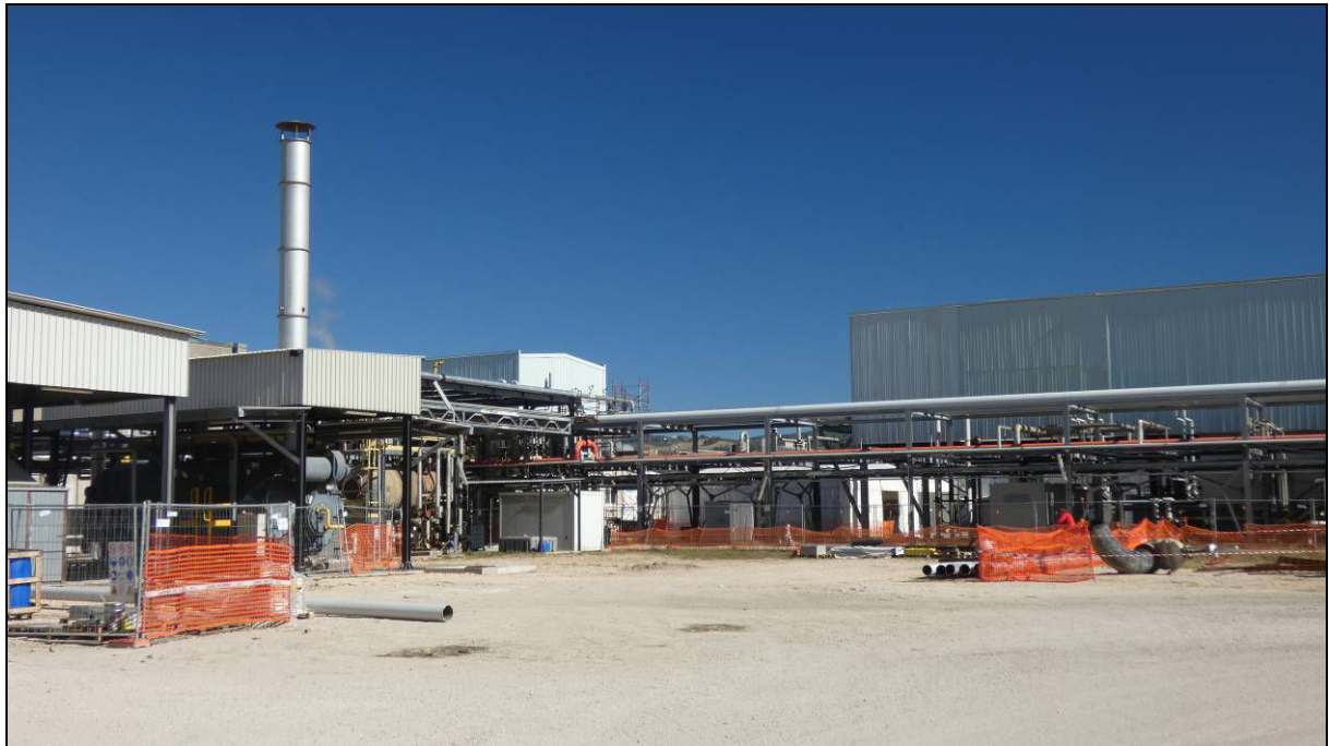
Figura 4.7.4/2 Sito di prevista localizzazione dell'impianto in progetto
