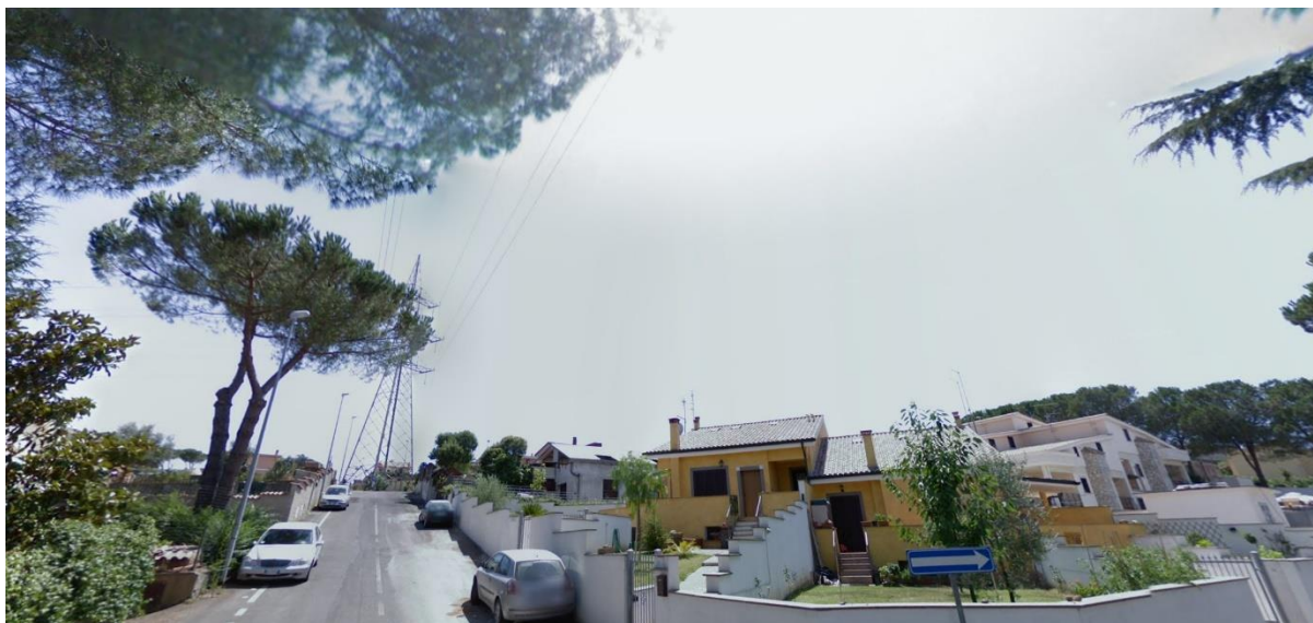
Figura 13-4 - Linea esistente 150 kV DT "Laurentina- Roma Sud" Veduta del sostegno n.2 in direzione sud
