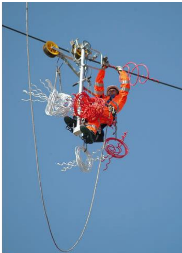
Figura 9-13 - Montaggio dissuasori di segnalazione per avifauna
