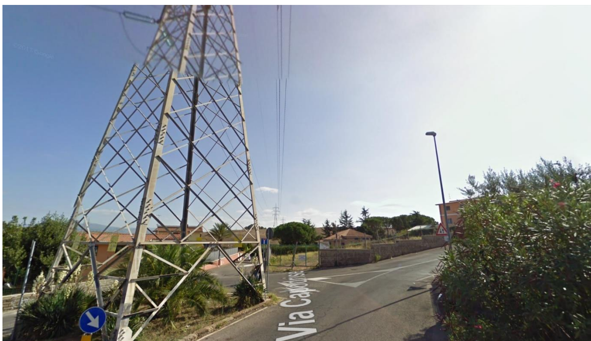
Figura 13-5 - Linea esistente 150 kV DT "Laurentina- Roma Sud" Veduta del sostegno n.2 in direzione est (verso la stazione elettrica di Roma Sud)
