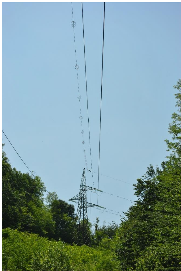
Figura 9-12 - Dispositivi di segnalazione per avifauna
