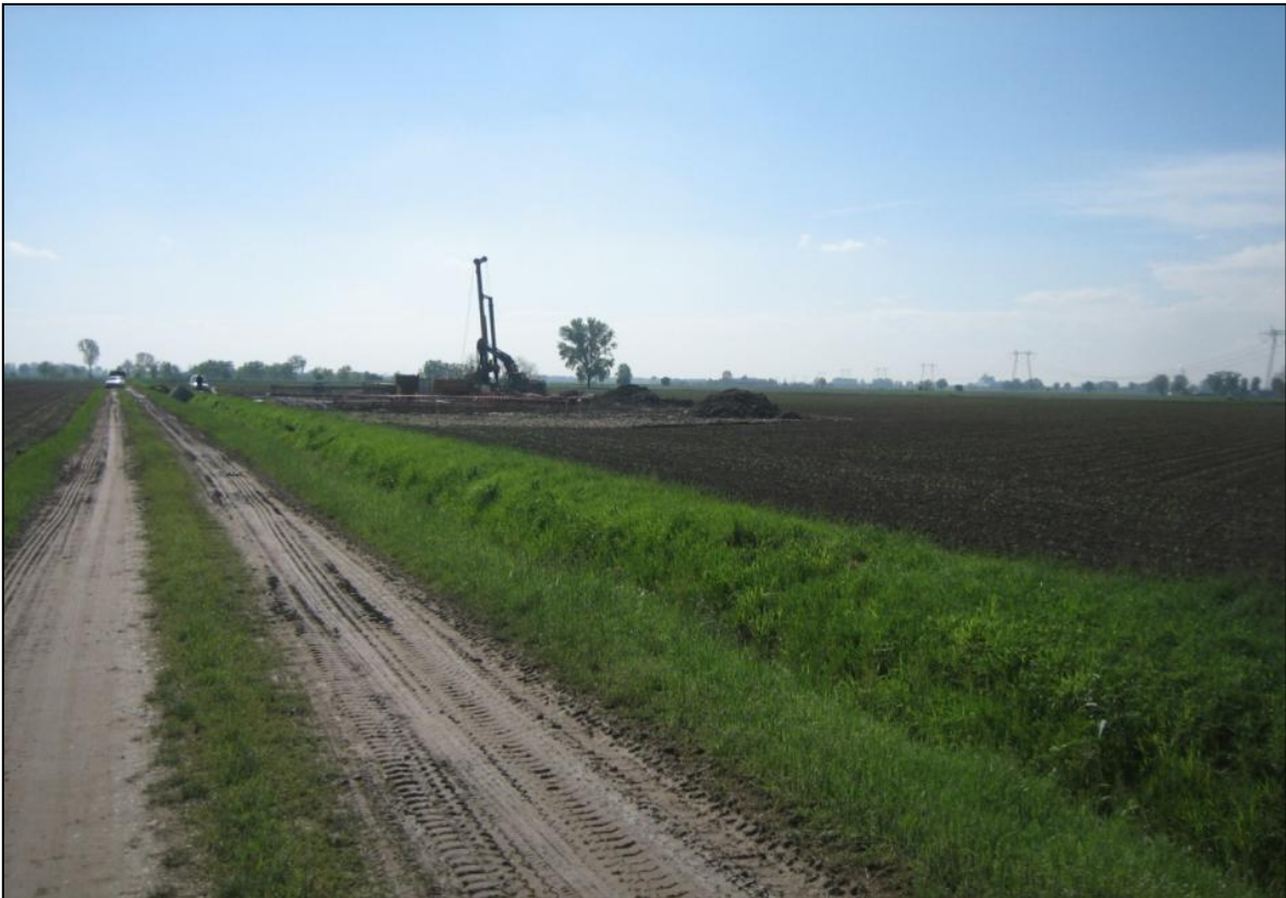
Figura 4-4 - Esempio di micro cantiere con pista di accesso
