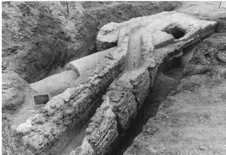
**Gli acquedotti della valle di Malafede, particolare della sovrapposizione delle due strutture**
