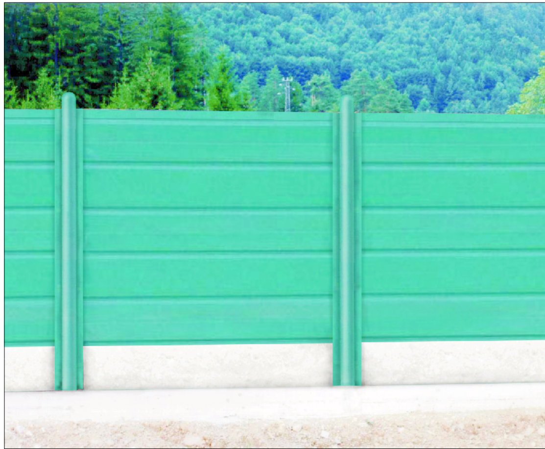
Foto - prospetto barriera (lato strada)
