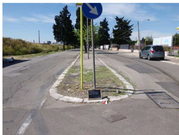
Figura 31 – Vista da sud est del metanodotto da dismettere in via San Brunone.
