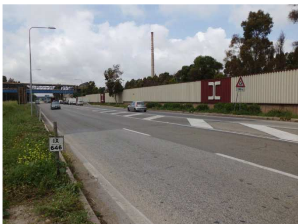
Figura 9 – Vista da sud-ovest della part. 142.
