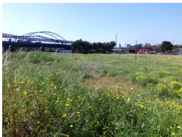
Figura 20 –Vista da ovest della part.22
