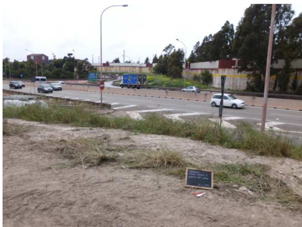
Figura 14 –Vista da est del cavalcavia di svincolo tra la SS7 e la SS7ter.
