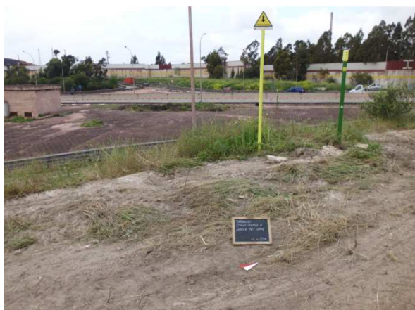
Figura 26 –Vista da sud est del metanodotto da dismettere nell’area del cavalcavia di svincolo tra la SS7 e la SS7ter.
