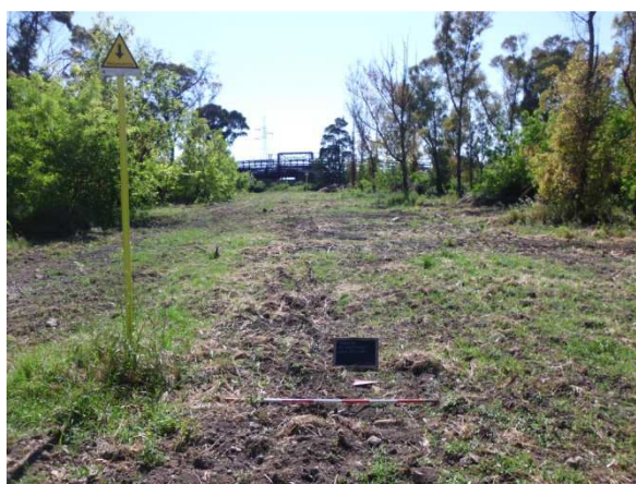
Figura 29 – Vista da sud est del metanodotto da dismettere nelle part. 15,16.
