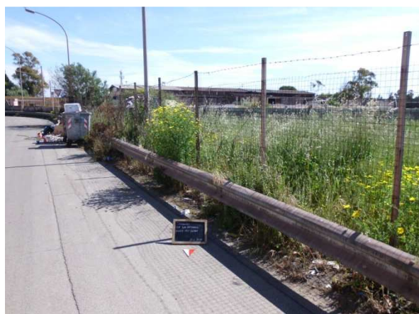
Figura 30 –Vista da nord della part. 258
