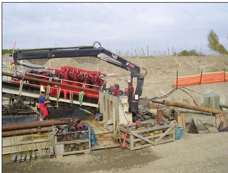
Fig. 1.6/B: Attravers. F. Po con met. 30” – “Rig”, durante la realizzazione del foro pilota
