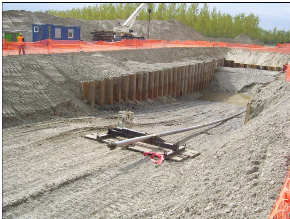
Fig. 1.6/C: Attraversamento F. Po con met. 30” – fase di uscita dell’asta pilota
