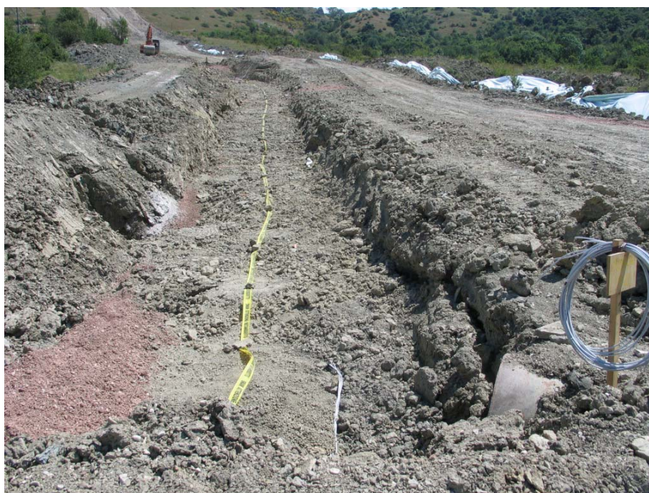
Foto 3.H: Esempio di rinterro della condotta.
