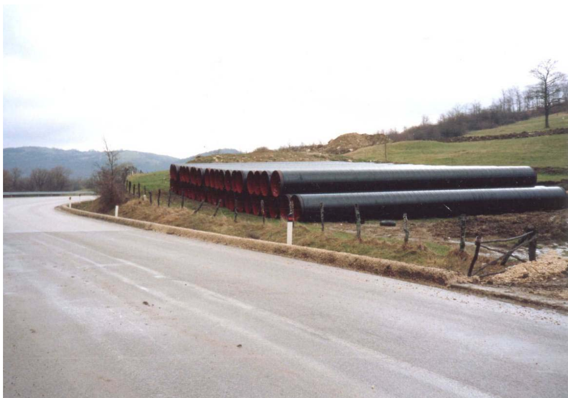
Foto 3.B: Esempio di piazzola di accatastamento tubazioni
