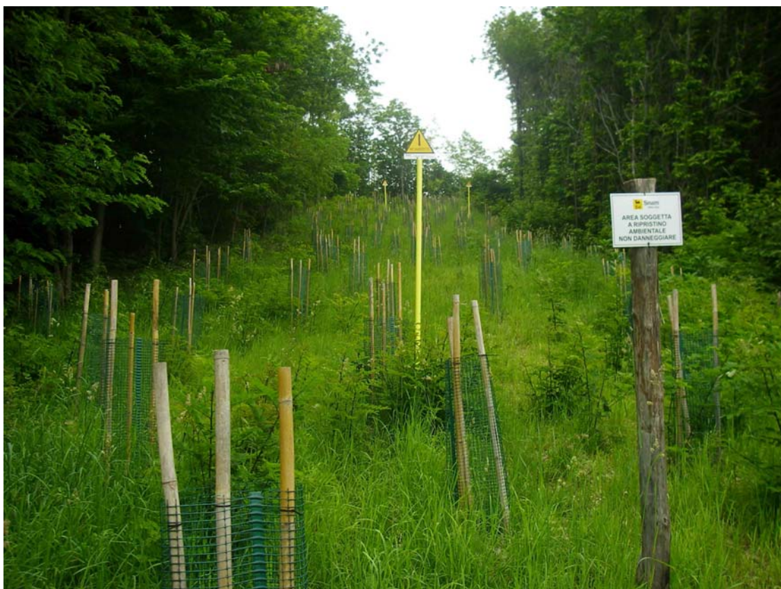
Foto 3.L: Esempio di ripristino vegetazionale con inerimento e messa a dimora di alberi ed arbusti.
