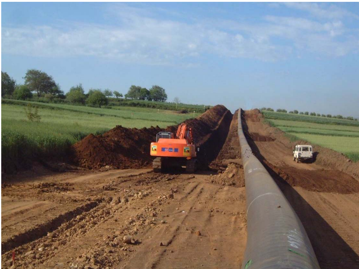
Foto 3.F: Esempio di scavo in trincea
