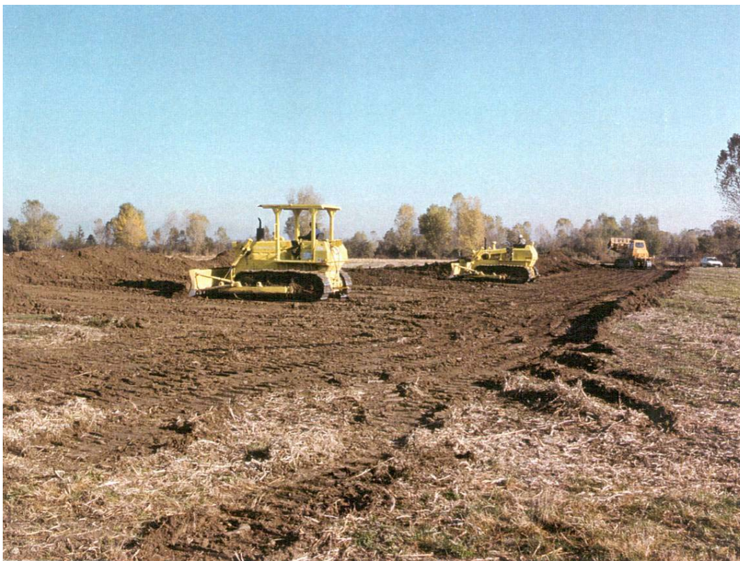
Foto 3.C: Esempio di apertura dell'area di passaggio
