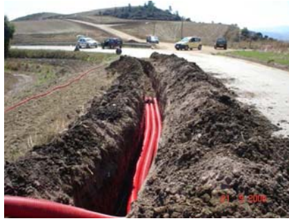
Fig. 1.6 - Foto illustrativa della messa in posa dei cavidotti MT
