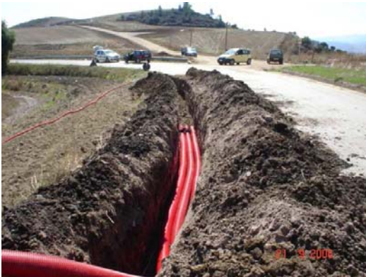
Fig. 1.3 - Foto illustrativa della messa in posa dei cavidotti MT
