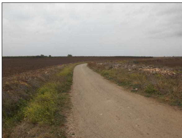
78. Elettrodotto tra la stazione elettrica ed il secondo punto di raccolta, località Marana della Difensola/C. M. S. S. d'Altomare
