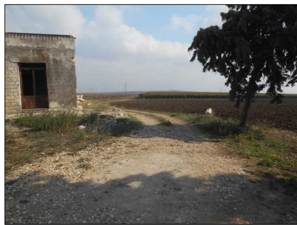
21. Elettrodotto esterno di interconnessione in località Pozzilli
