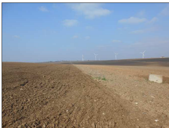
17. Elettrodotto esterno di interconnessione in località Cerolla
