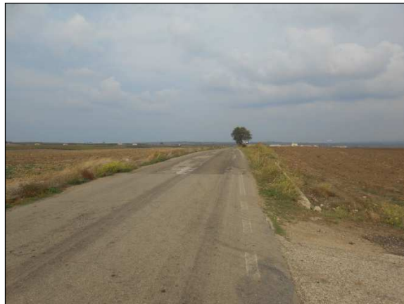
69. Elettrodotta lungo la SP 31, località Mass. Difensola
