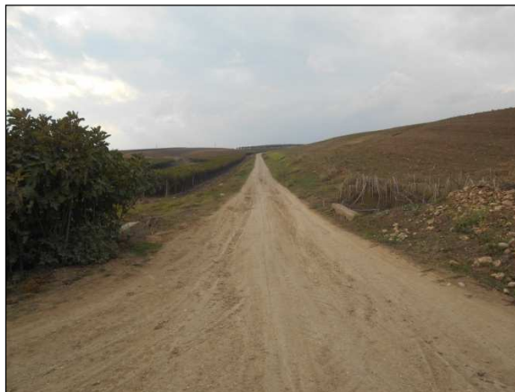
73. Elettrodoto lungo la strada Vicinale Serracannola Apricana, località Marana della Difensola
