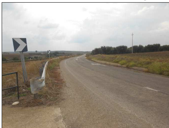
68. Elettrodotta lungo la SP 31, località Mass. Difensola
