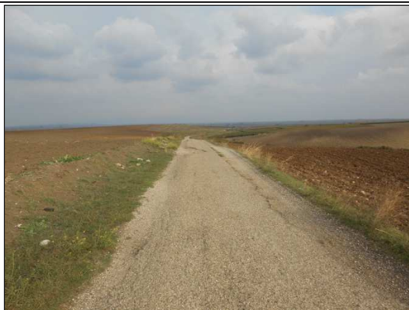
70. Elettrodoto lungo la strada Vicinale Serracannola Apricana, località Marana della Difensola
