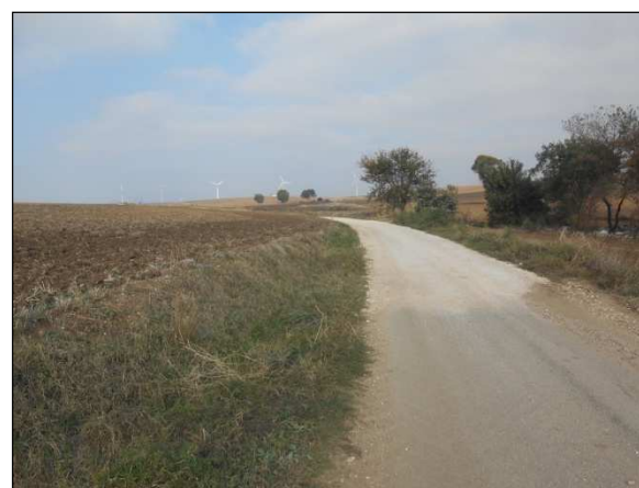
16. Elettrodotta esterno di interconnessione in località Cerolla
