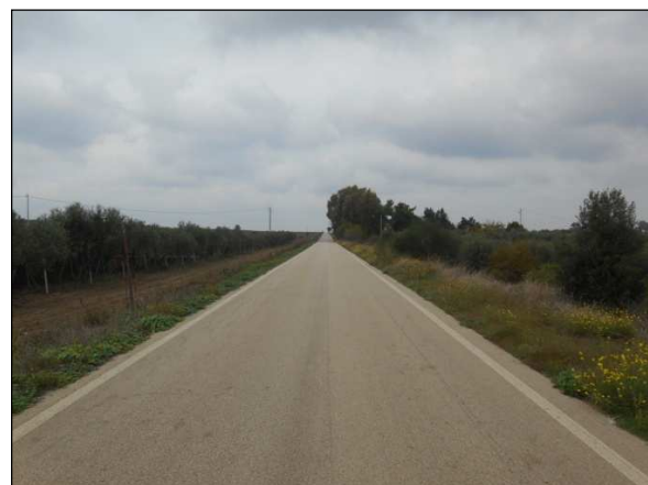
51. Elettrodotto lungo la SP 31, località Mass. Coppa di Rose
