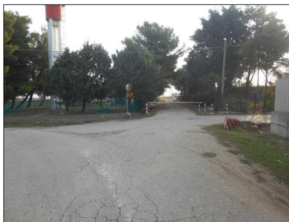
23. Elettrodotto esterno di interconnessione in direzione della SS 16, località Mass. dei Frati Minori
