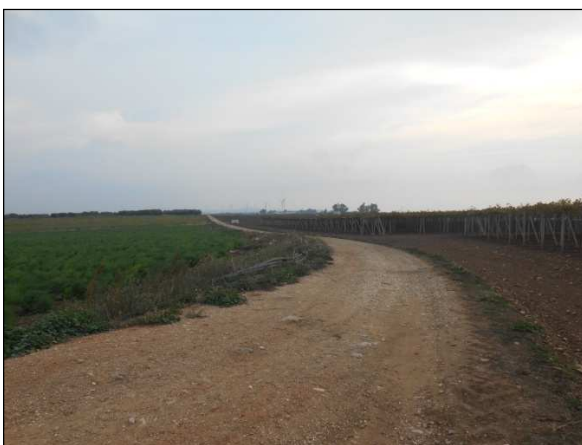
27. Elettrodotto esterno di interconnessione, località Il Titolone
