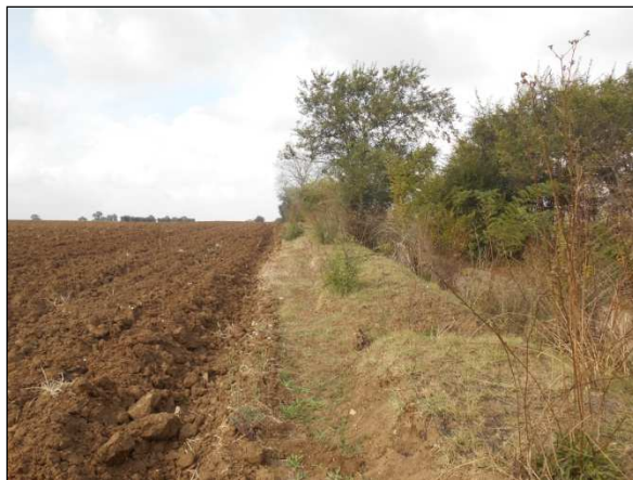
39. Elettrodotta esterna di interconnessione lungo la SP 39, località C.S. Michele
