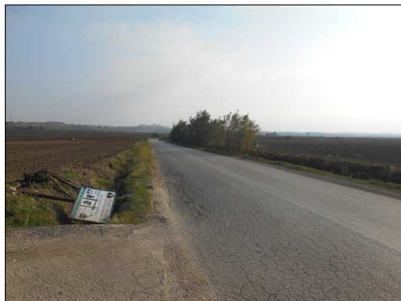
12. Elettrodotta lungo la SP 36 tra turbina 6 e 5, località Mass. Di Lorenzo
