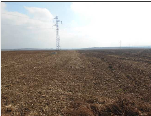
18. Elettrodotto esterno di interconnessione in località Pozzilli
