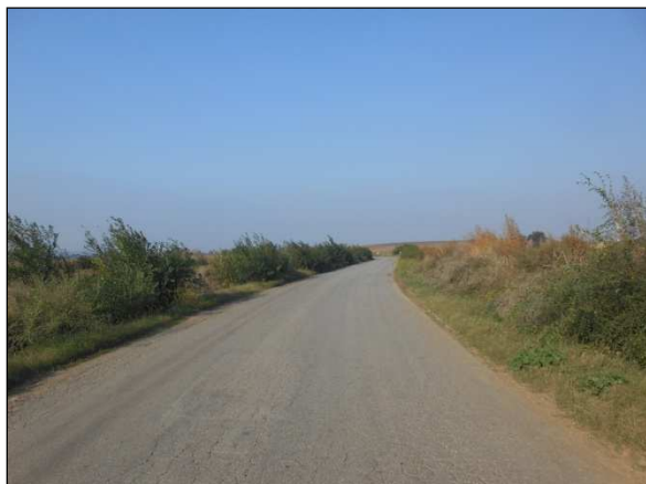
11. Elettrodotta lungo la SP 36 tra turbina 6 e 5, località Mass. Di Lorenzo
