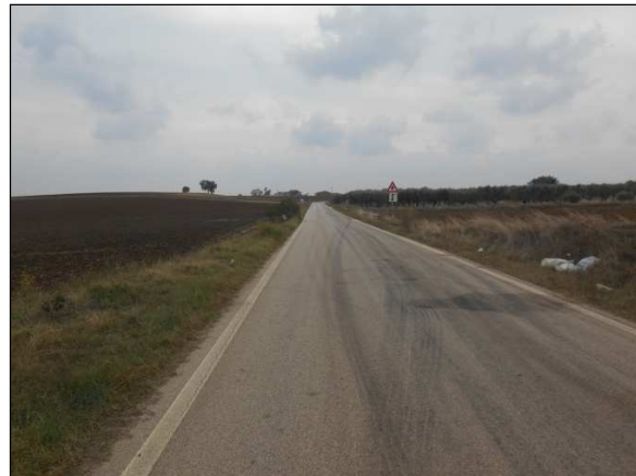
46. Elettrodotto lungo la SP 31, località Coppa di Rose
