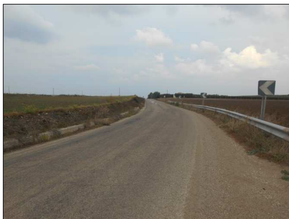
67. Elettrodotta esterno di interconnessione lungo la SP 31, località Mass. Difensola
