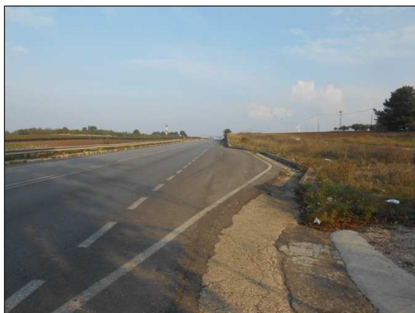
22. Elettrodotto esterno di interconnessione lungo la SS 16, località Pozzilli
