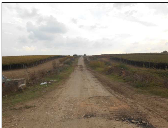
74. Elettrodoto lungo la strada Vicinale Serracannola Apricana, località Marana della Difensola
