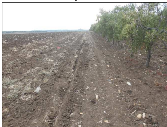
75. Elettrodoto in direzione della stazione elettrica, località Marana della Difensola/C. M. "S. S. d'Altomare"
