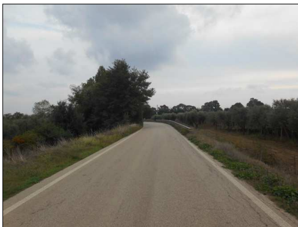
52. Elettrodotto lungo la SP 31, località Mass. Coppa di Rose
