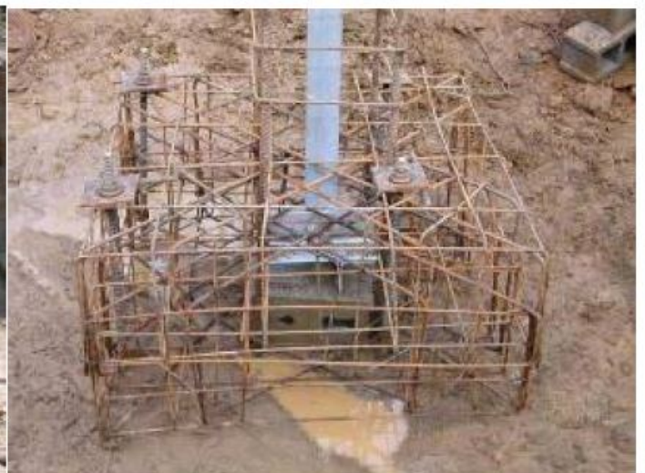
Figura 2 – Esempio di fondazione con tiranti in roccia
