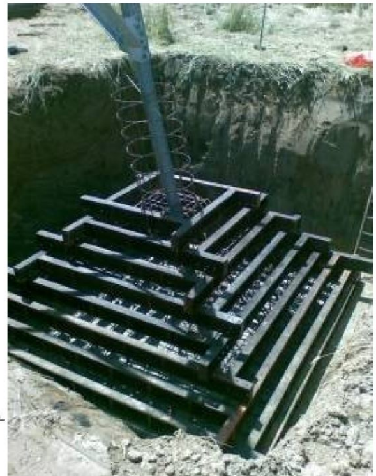
Figura 1 – Esempio di realizzazione di una fondazione a plinto con riseghe
