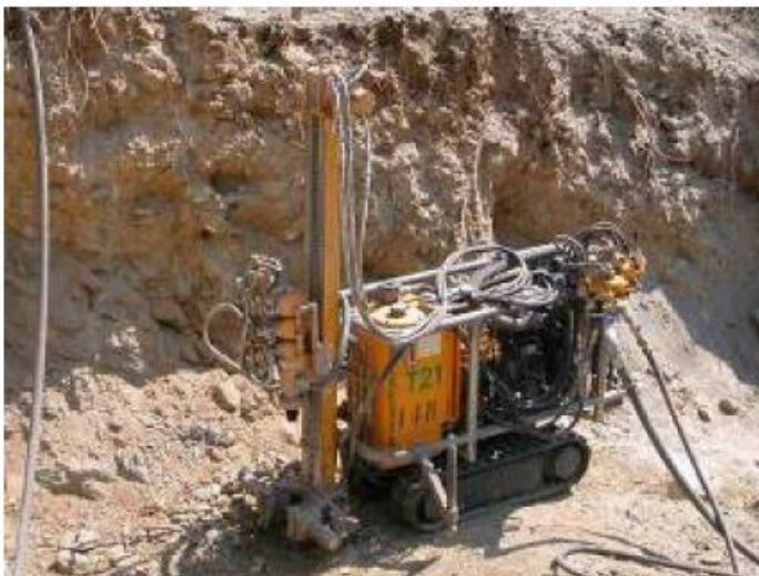
Figura 2 – Esempio di fondazione con tiranti in roccia
