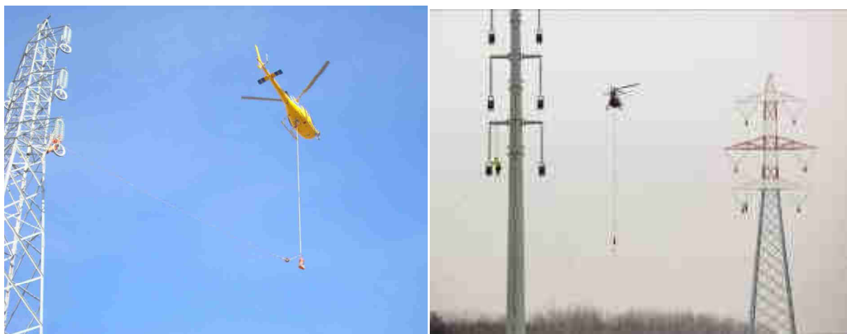
Utilizzo dell'elicottero per la stesura della fune pilota
