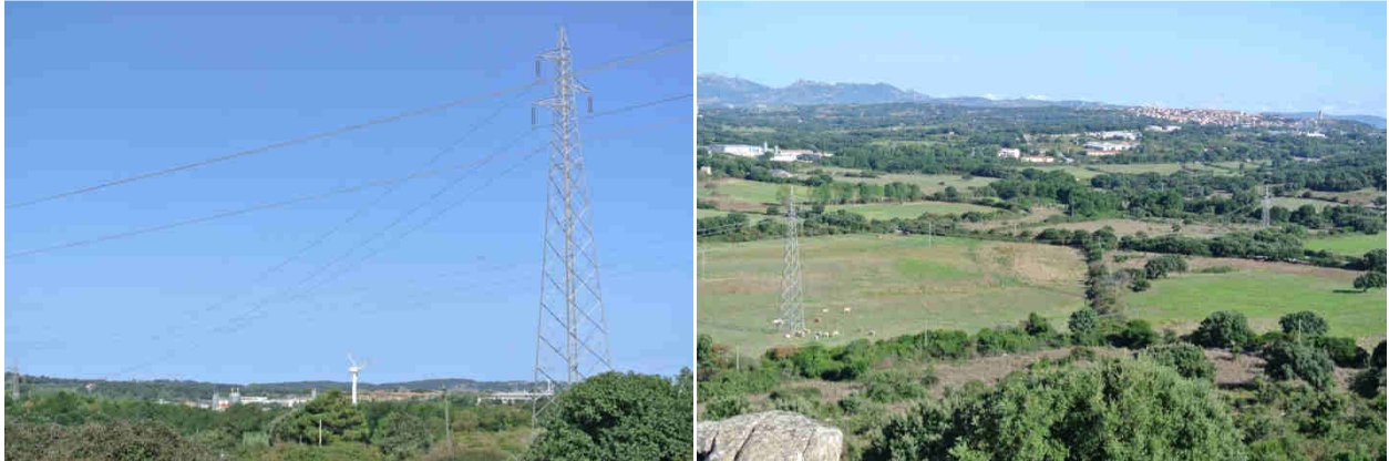
Demolizioni elettrodotto a 150 kV “Olbia-Tempio” – fotografie settembre 2018
