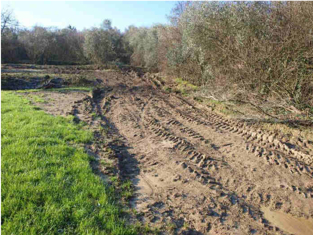
Figura 8-30: Le piste di accesso ai micro-cantieri dei nuovi tralicci verranno ripristinate a fine lavori.
