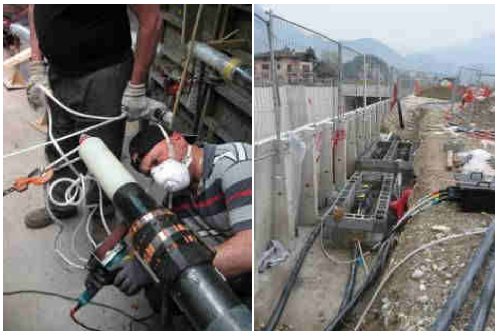
Esecuzione giunto esempio di buca giunti
