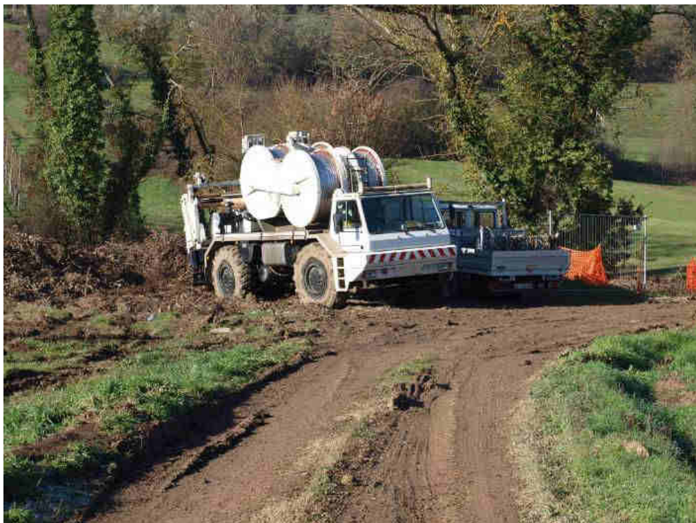
Figura 8-31: Idem c.s. (postazione di lavoro per tesatura conduttori).
