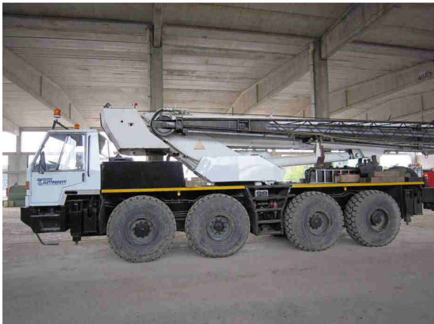
Area centrale – Mezzo utilizzato in fase di cantiere
