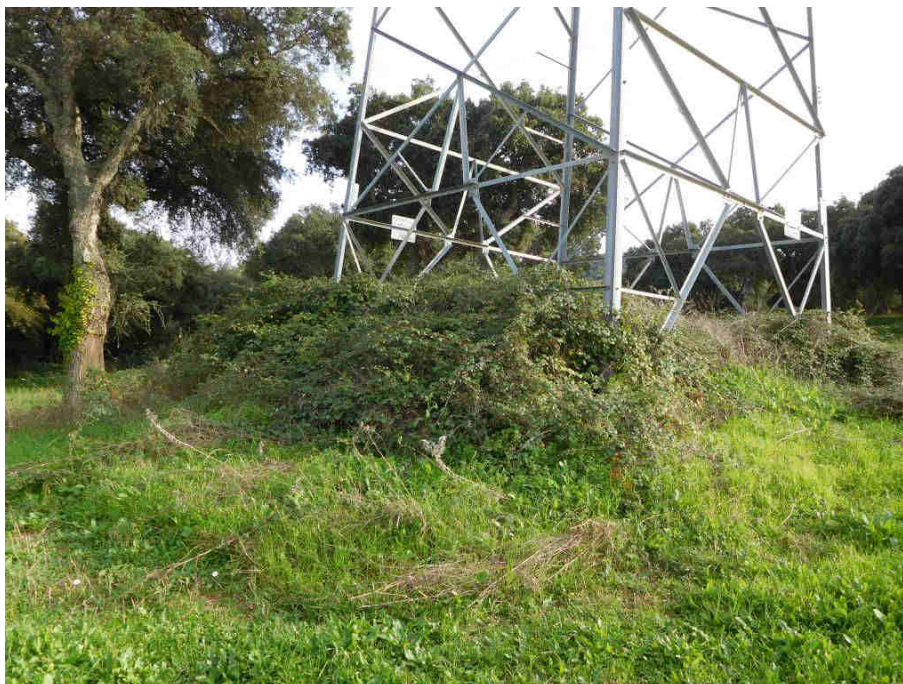
Fig. 3.8.2 – Area prossima al sostegno n. 9 da demolire.
