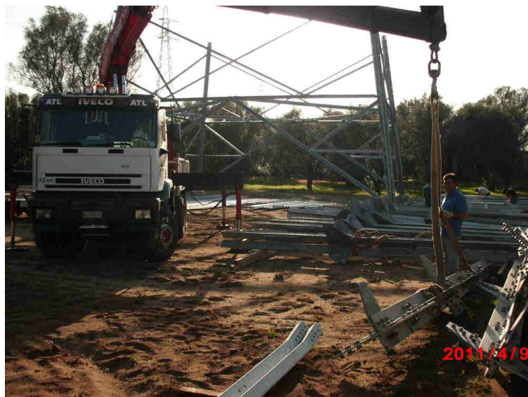
Fasi di montaggio sostegno a traliccio
