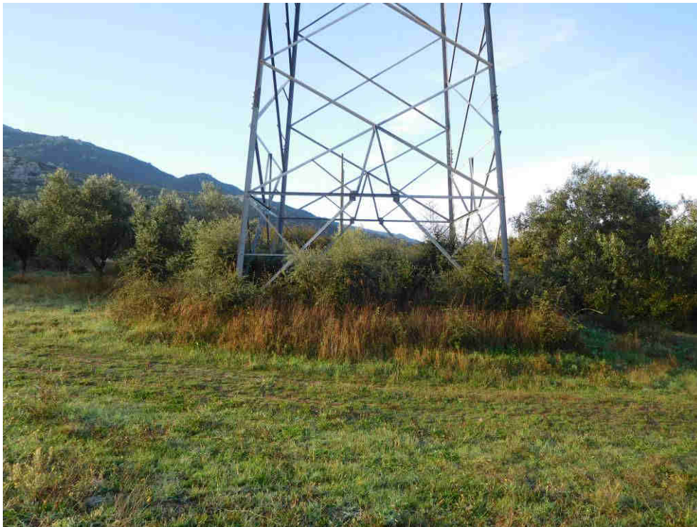
Fig. 3.1.2 – Area prossima al sostegno n. 2 da demolire.
