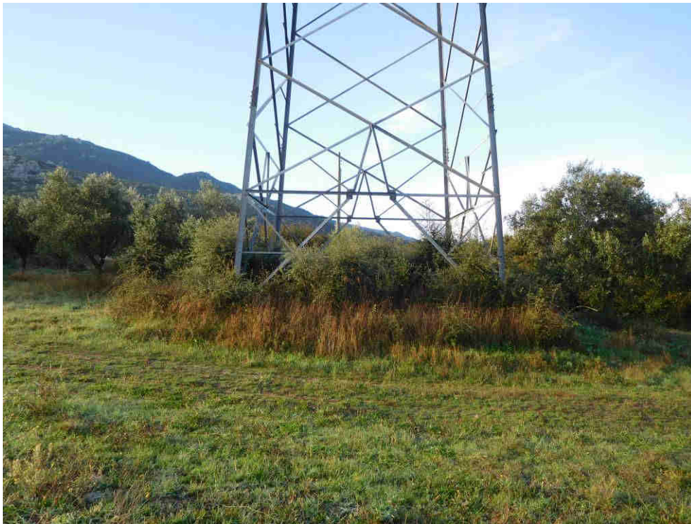
Fig. 3.1.2 – Area prossima al sostegno n. 2 da demolire.
