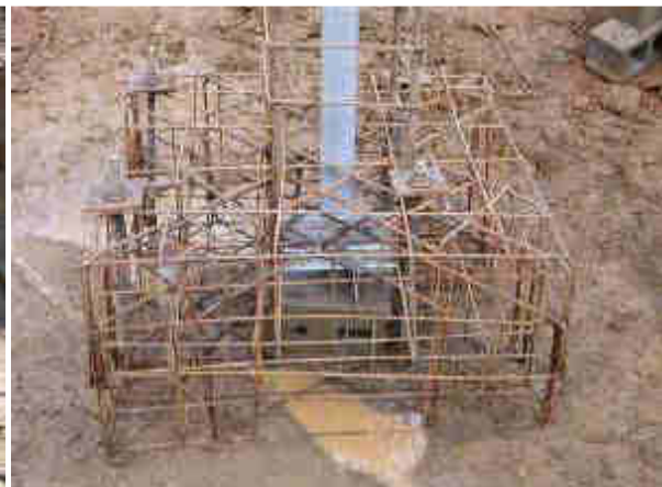
Esempio di fondazione con tiranti in roccia
