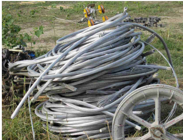
Fasi demolizione di un sostegno a traliccio
