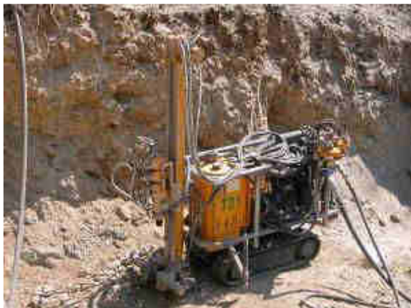
Esempio di fondazione con tiranti in roccia
