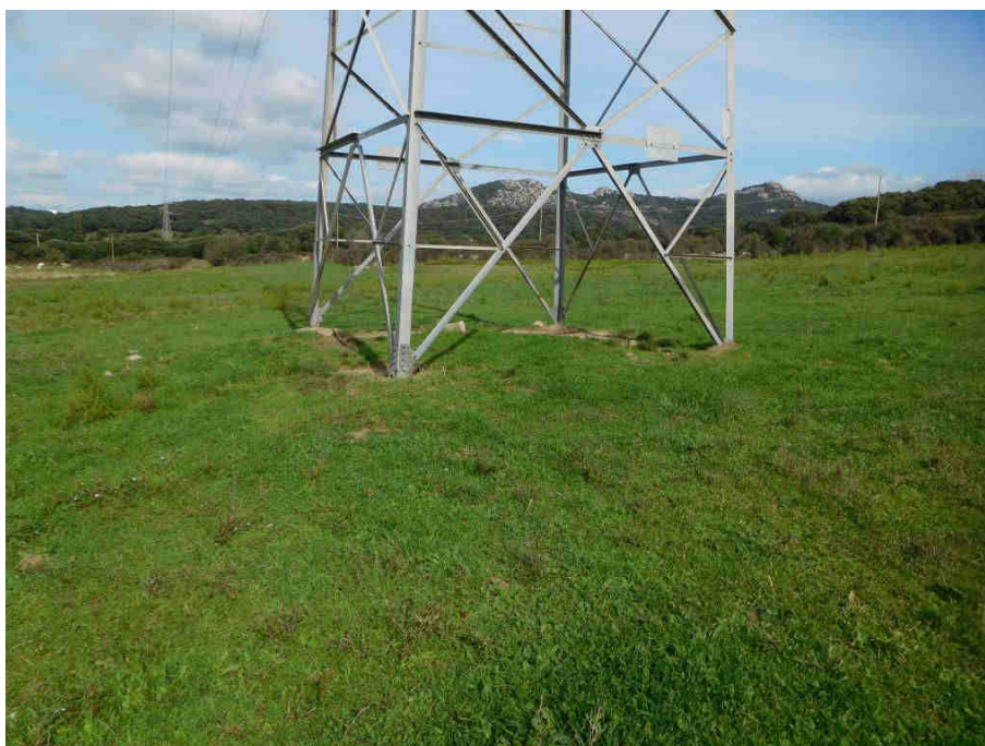
Fig. 3.6.2 – Area prossima al sostegno n. 7 da demolire.
