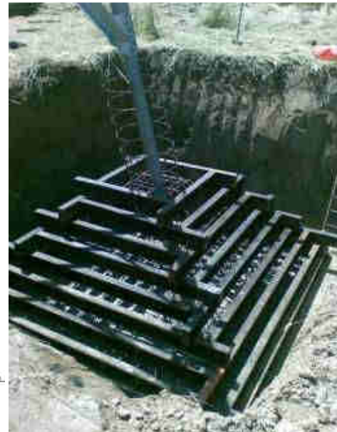
Esempio di realizzazione di una fondazione a plinto con riseghe. Nell'immagine di sinistra di può osservare un disegno di progetto mentre nell'immagine di destra la fase di cassatura della fondazione
