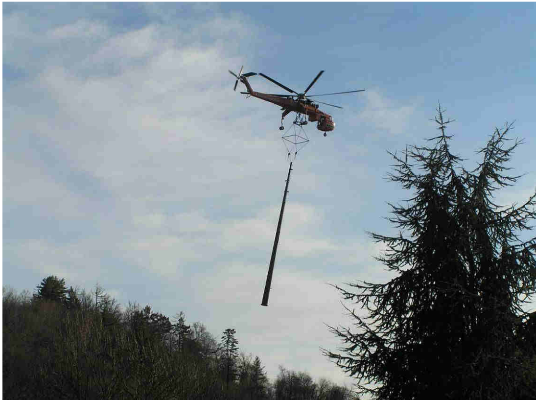
Figura 8-26: Trasporto di un sostegno con elicottero Erickson Air Crane S-64.
