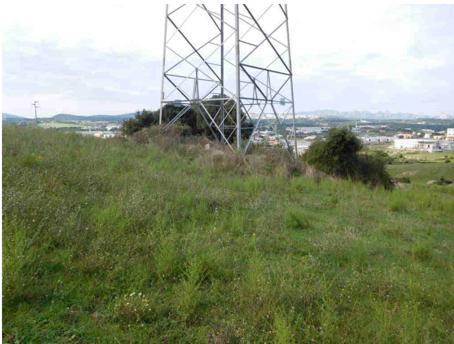
Fig. 3.4.2 – Area prossima al sostegno n. 5 da demolire.
