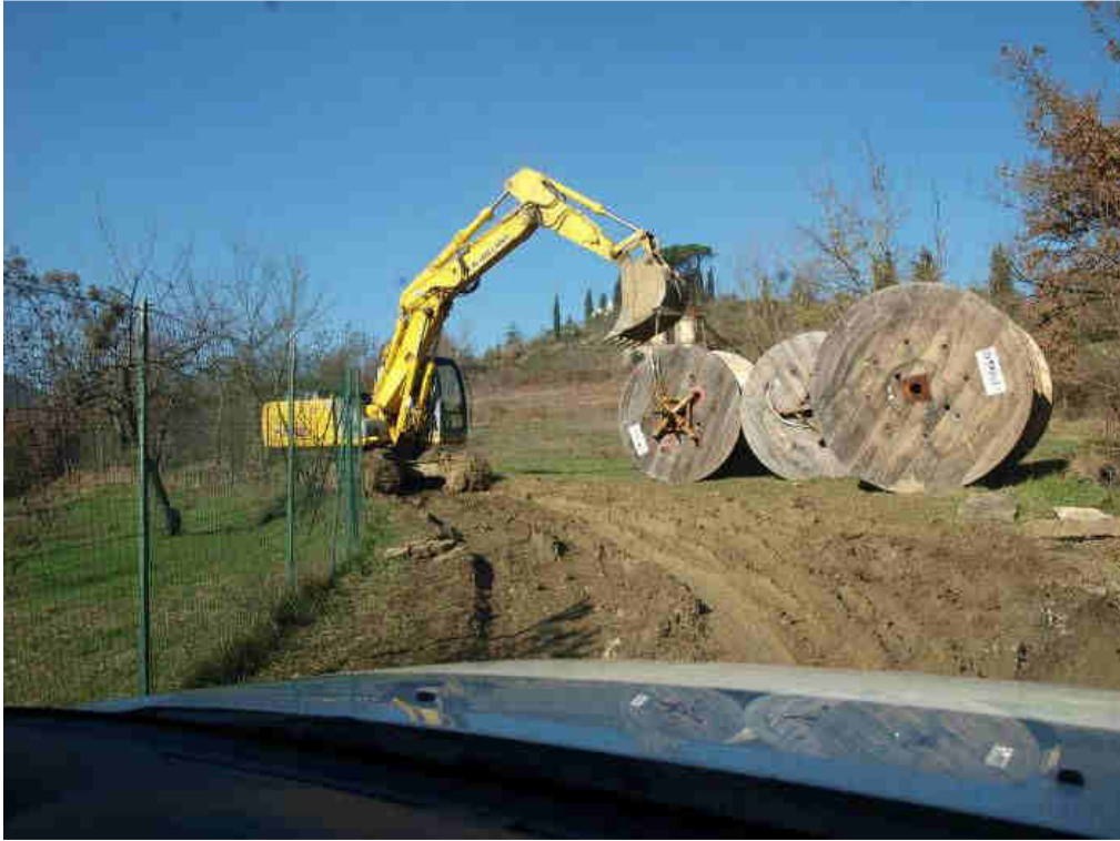
Figura 8-32: Trasporto dei conduttori tramite piste temporanee che vanno poi ripristinate a fine lavori.
