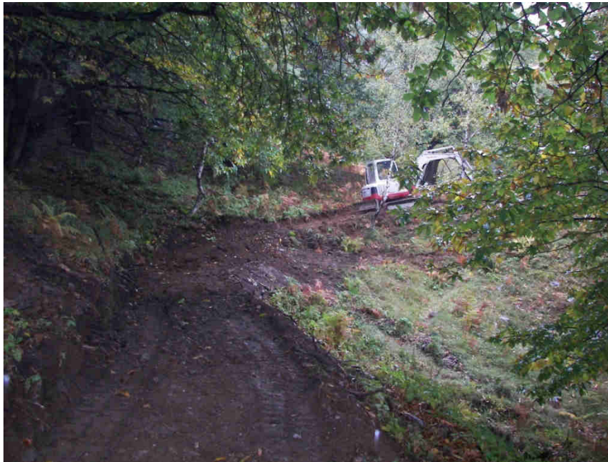
Foto raffigurante un esempio di pista di cantiere Tipo II.
