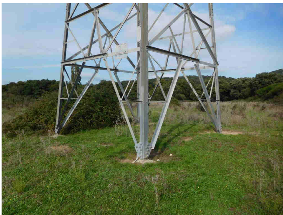
Fig. 3.7.2 – Area prossima al sostegno n. 8 da demolire.
