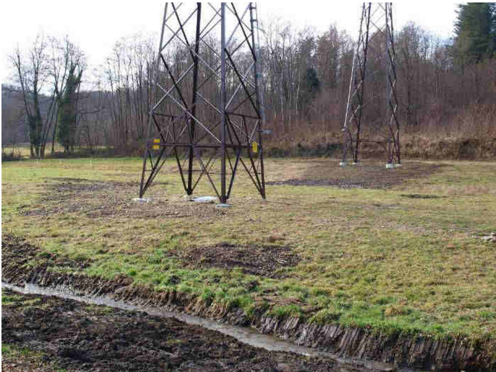
Figura 8-33: Nuovi tralicci e ricomposizione in aree a prato.
