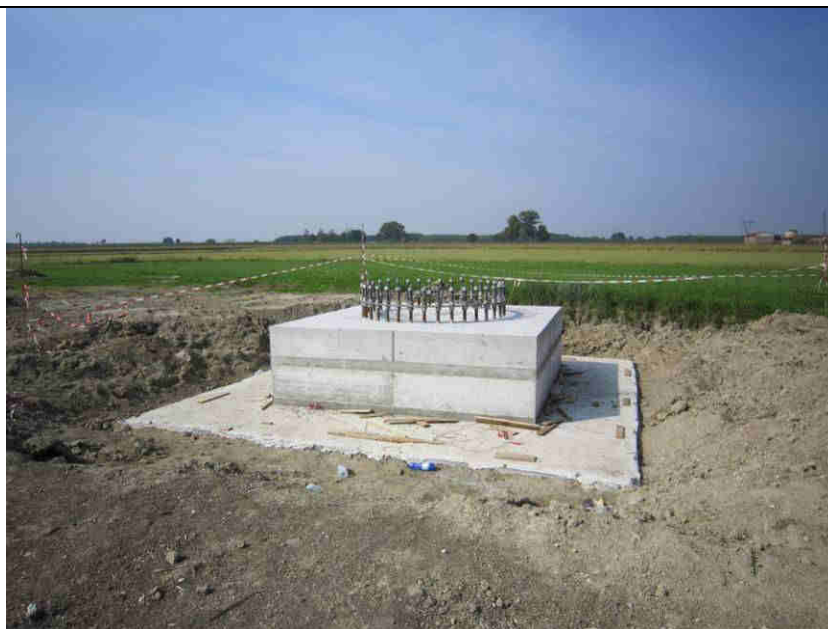
Realizzazione di fondazione superficiale tipo plinto a monoblocco per un sostegno monostelo. Nell'immagine si può osservare la fase di cassetatura
