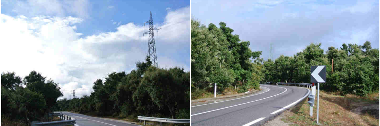
Demolizioni elettrodotto a 150 kV “CP Buddusò – Siniscola” – fotografie settembre 2018
