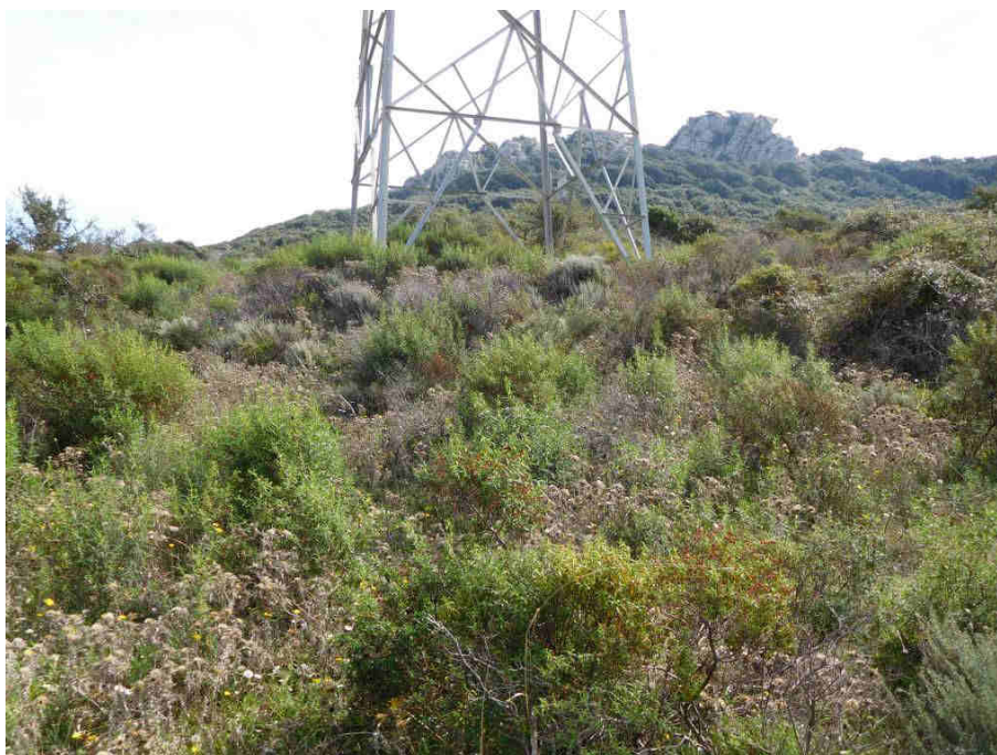
Fig. 3.5.2 – Area prossima al sostegno n. 6 da demolire.
