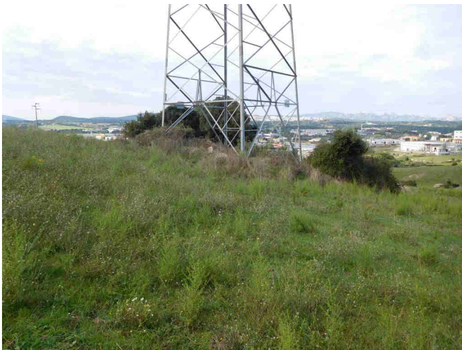
Fig. 3.4.2 – Area prossima al sostegno n. 5 da demolire.
