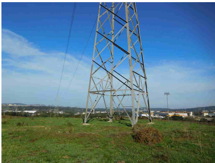
Fig. 3.2.2 – Area prossima al sostegno n. 3 da demolire.
