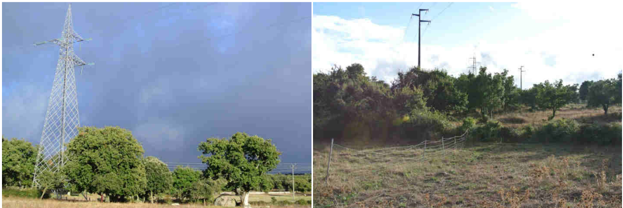
Demolizioni elettrodotto a 150 kV “CP Buddusò – Bono” – fotografie settembre 2018
