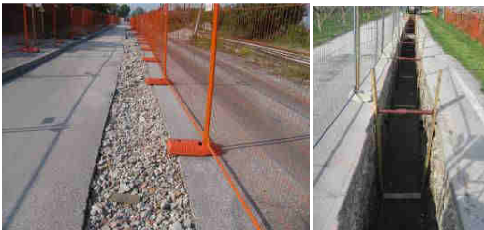
Taglio dell'asfaltatura e scavo aperto
