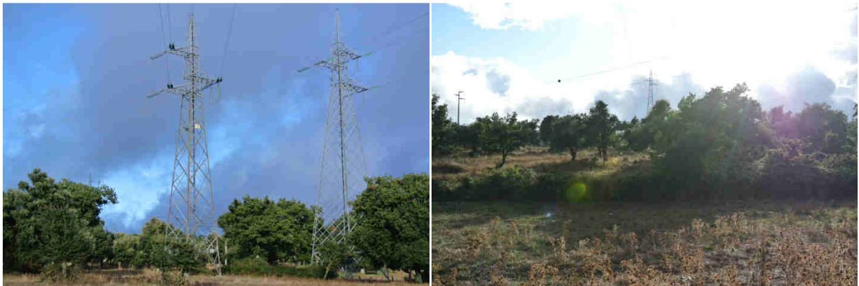
Demolizioni elettrodotto a 150 kV “Ozieri – CP Buddusò” – fotografie settembre 2018
