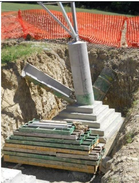
Realizzazione di fondazioni superficiali tipo CR per un sostegno a traliccio. Nell'immagine si può osservare una fondazione CR appena “scasserata”. Si possono distinguere facilmente la parte inferiore a parallelepipedi tronco piramidali ed il colonnino di raccordo con la “base” del sostegno
