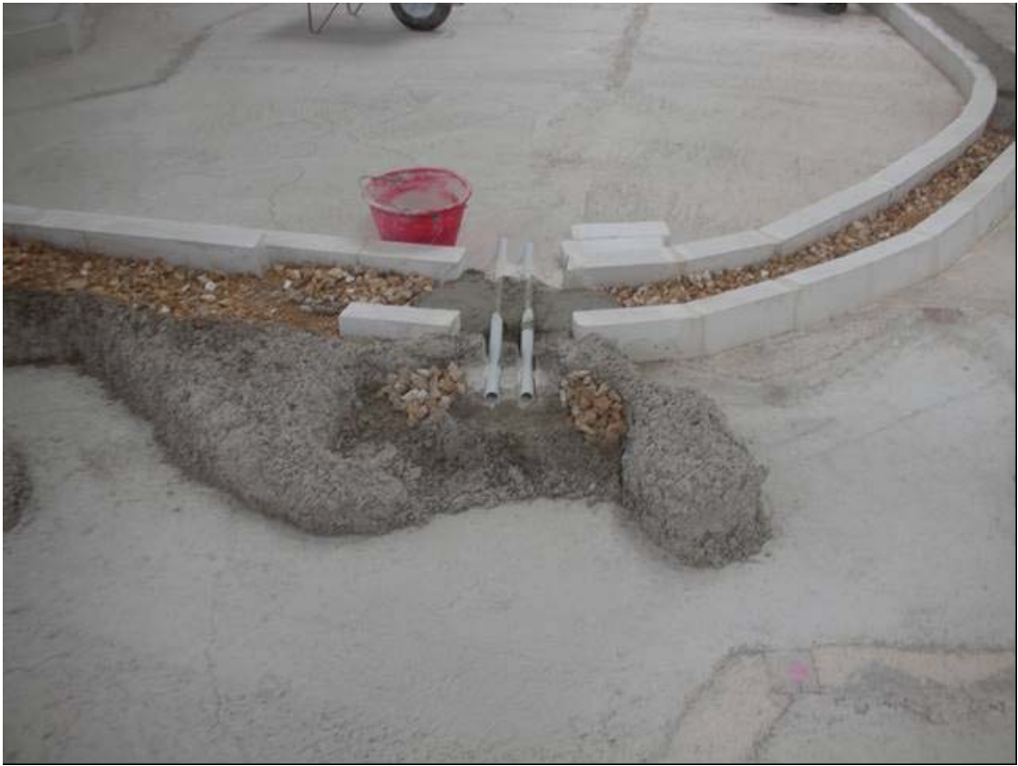
Fig. 2.34: Fase iniziale della posa dei condotti di ricircolo del porticciolo
