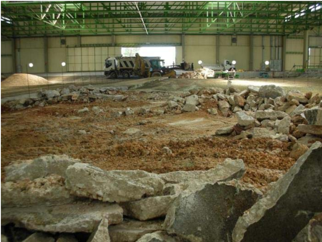
Fig. 2.7: fase di costruzione del modello: demolizione modello preesistente.
