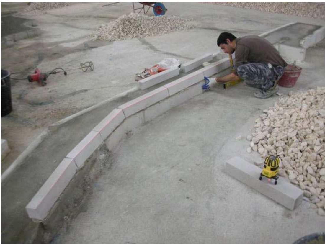
Fig. 6.3.1.10: posa in opera del muro di coronamento
