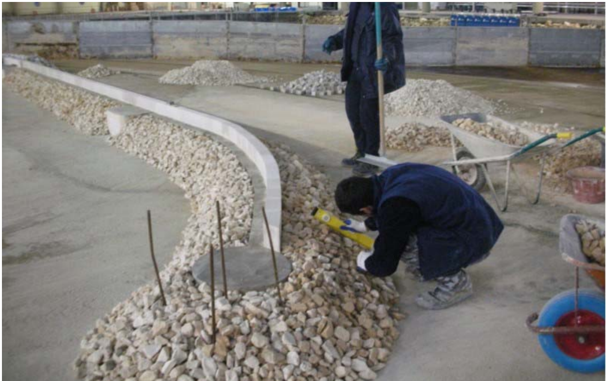
Fig. 6.3.1.6: un particolare del muro paraonde del nuovo molo di sopraflutto
