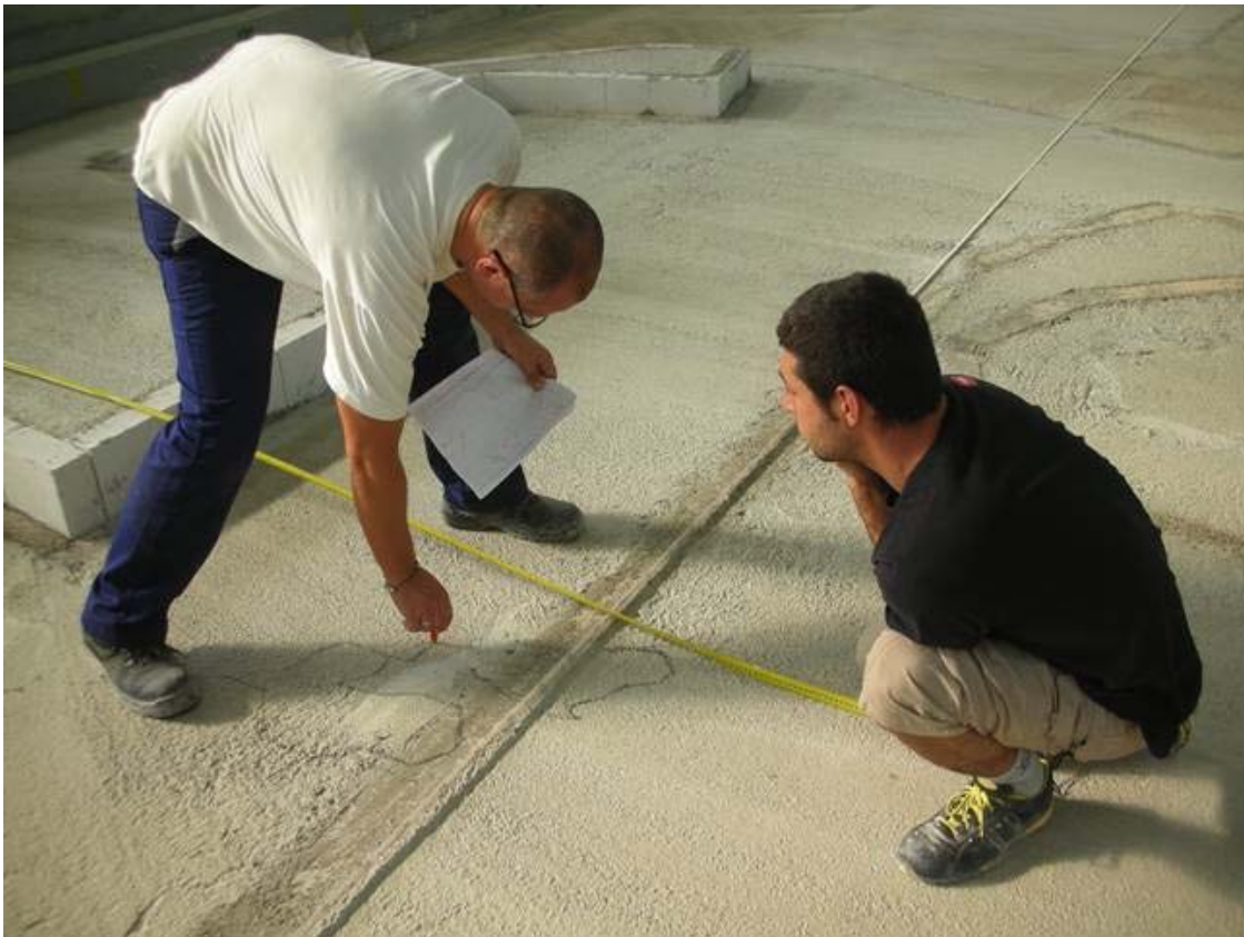
Fig. 2.16: Operazioni di tracciamento della costiera a terra.
