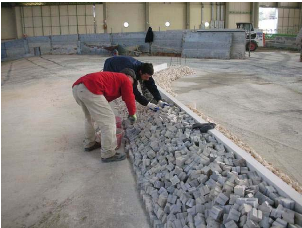
Fig. 6.3.1.7: posa in opera dei massi di mantellata del nuovo molo di sopraflutto
