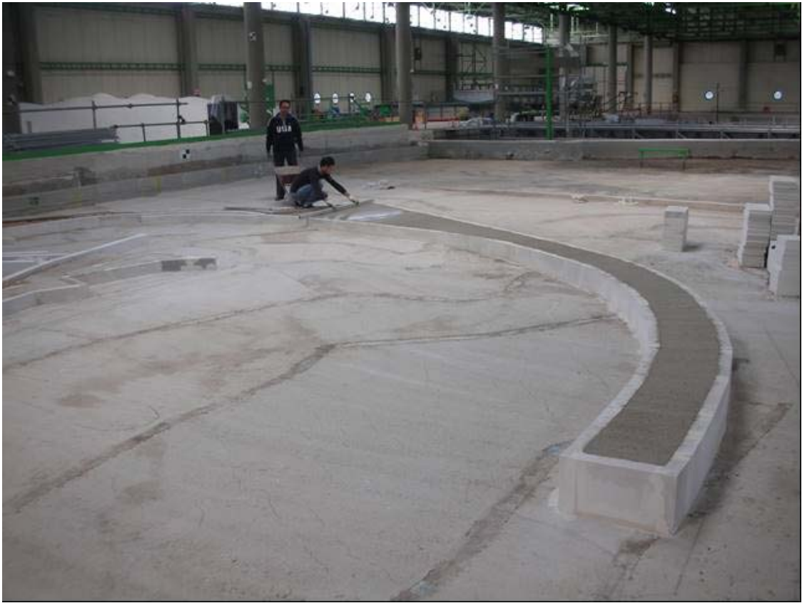
Fig. 2.29: Realizzazione della banchina del molo di sopraflutto. Getto di calcestruzzo finale.
