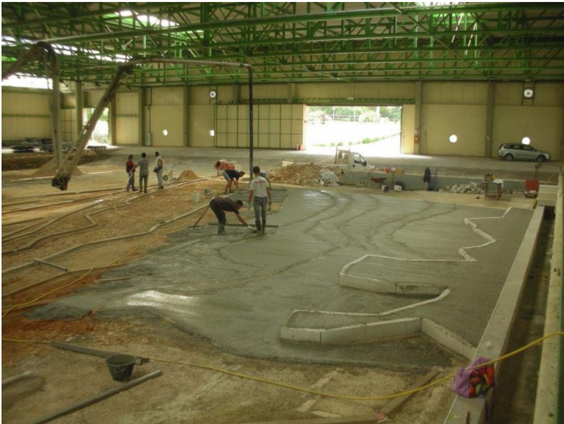
Fig. 2.13: Livellamento del calcestruzzo tra le batimetriche. Vista da nord
