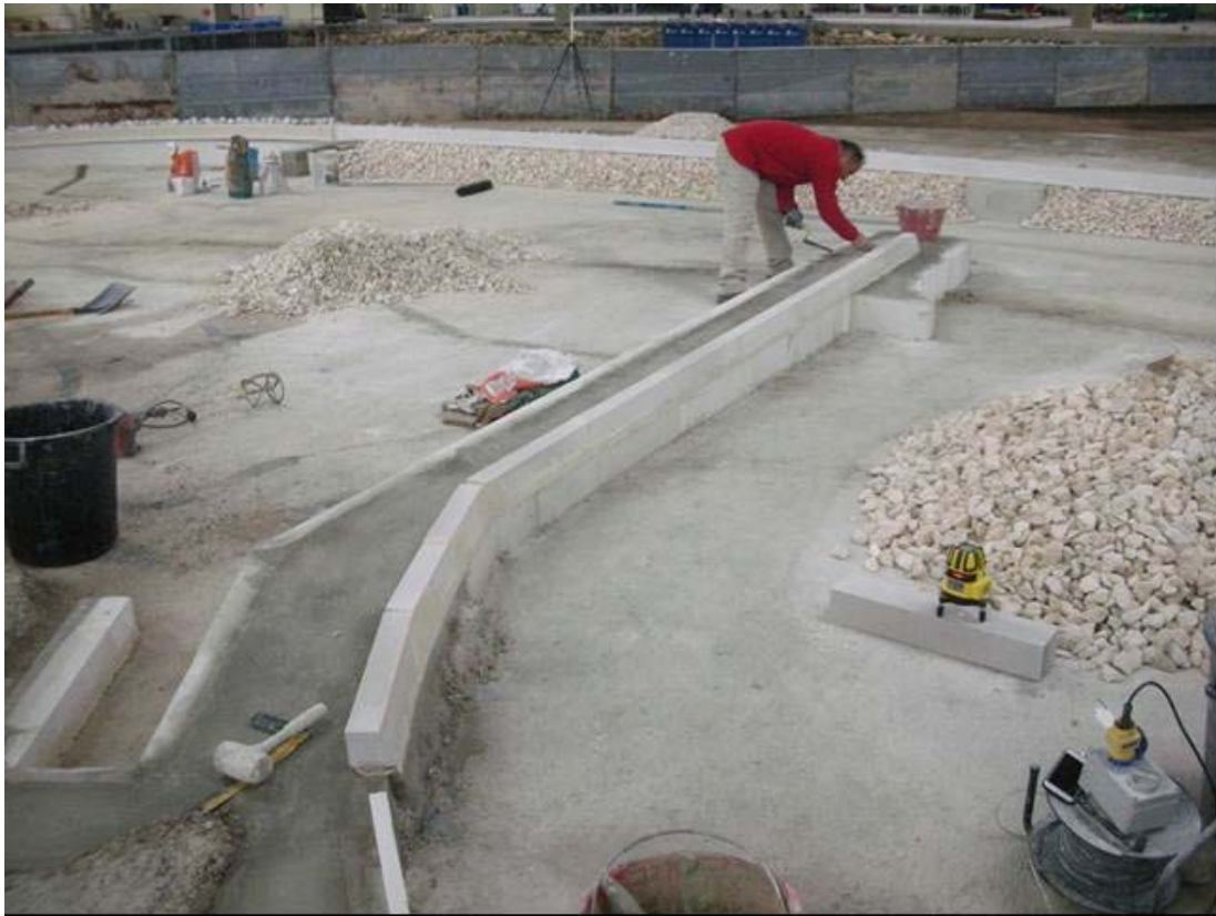
Fig. 6.3.1.11: completamento della superficie della banchina
