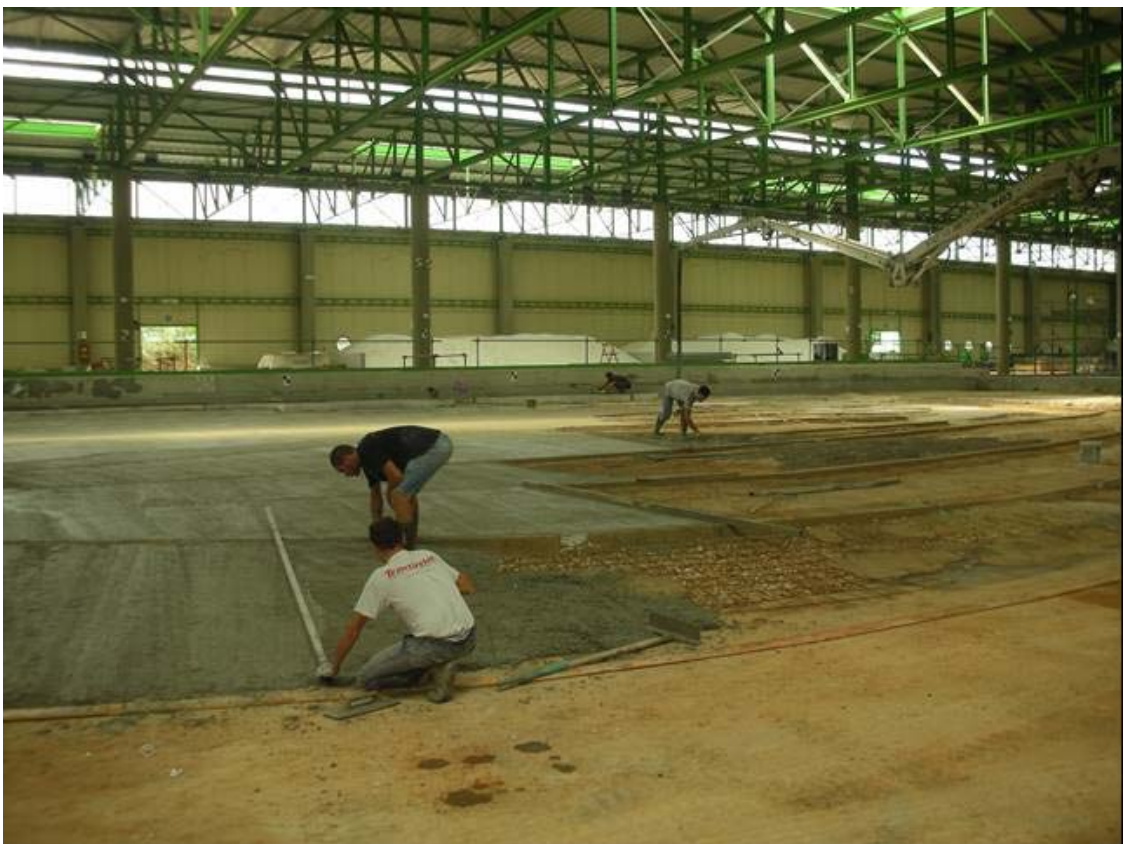
Fig. 2.15: Completamento della rampa di collegamento con il fondo vasca.
