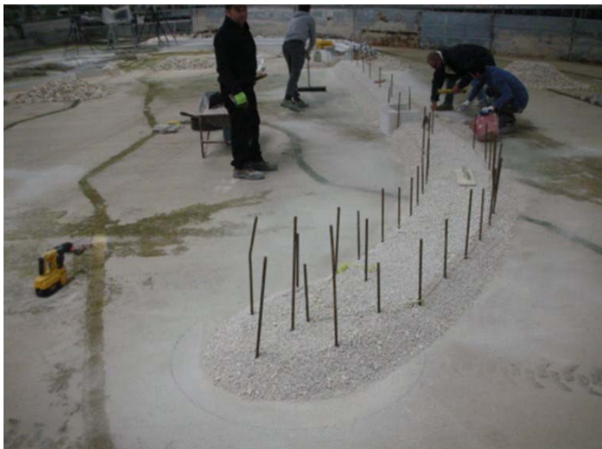
Fig. 6.3.1.3: lavori di costruzione del nucleo del nuovo molo di sopraflutto
