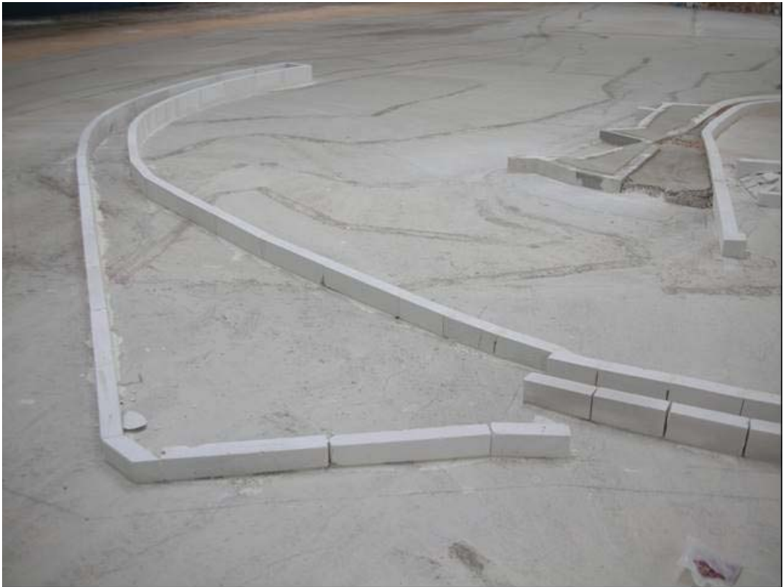
Fig. 2.27: Realizzazione della banchina del molo di sopraflutto. Sistemazione dei mattoni di bordo.
