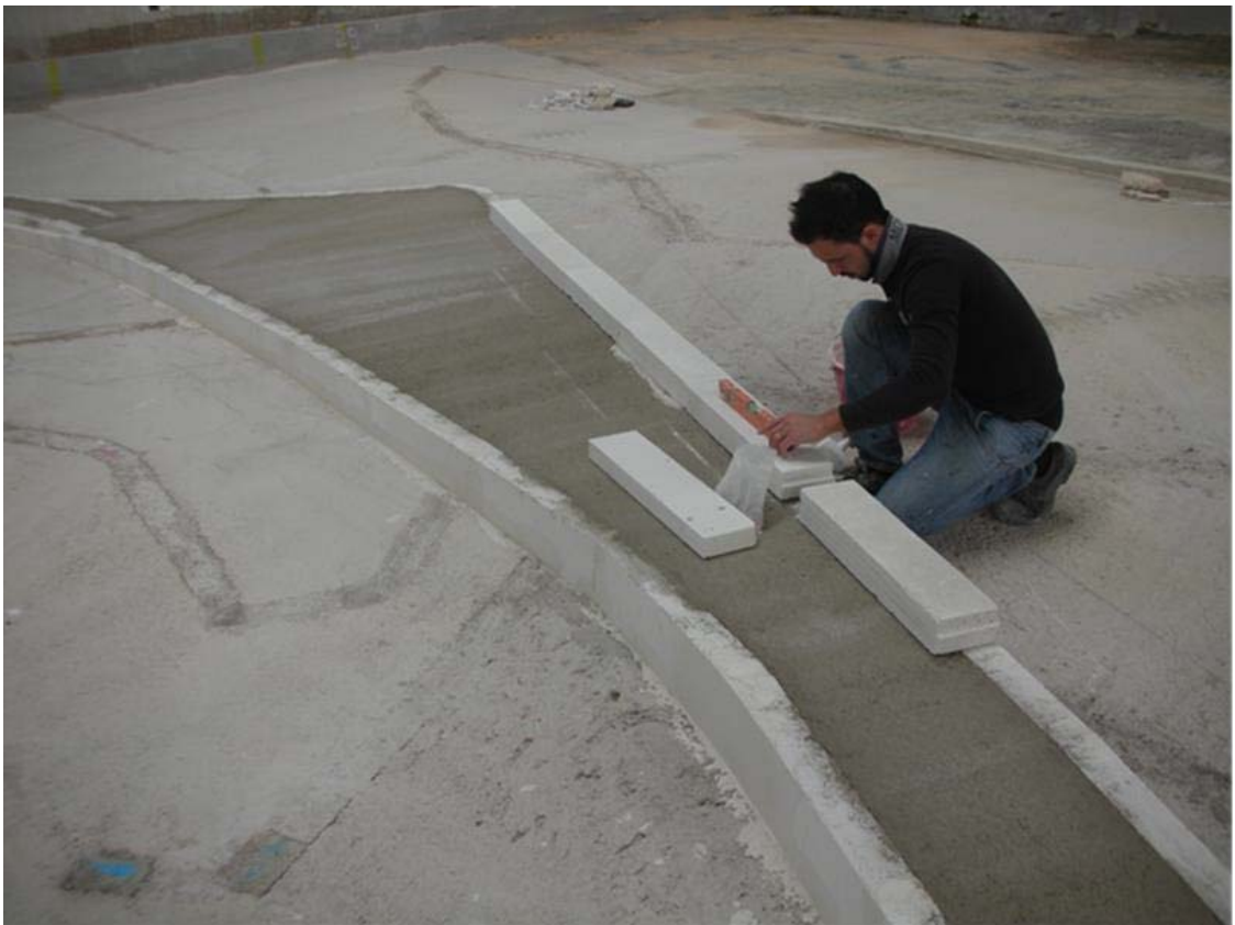
Fig. 2.30: Realizzazione del muro paraonde. Vista da mare
