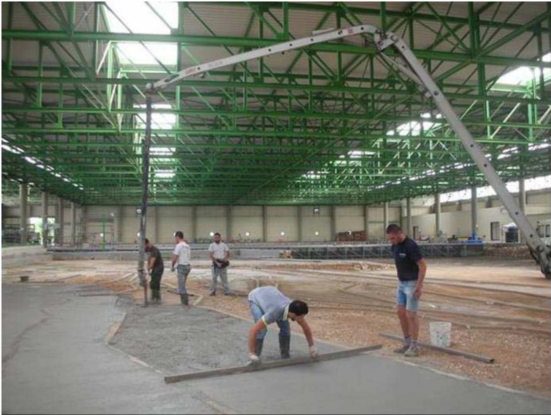
Fig. 2.12: Livellamento del calcestruzzo tra le batimetriche. Vista da sud
