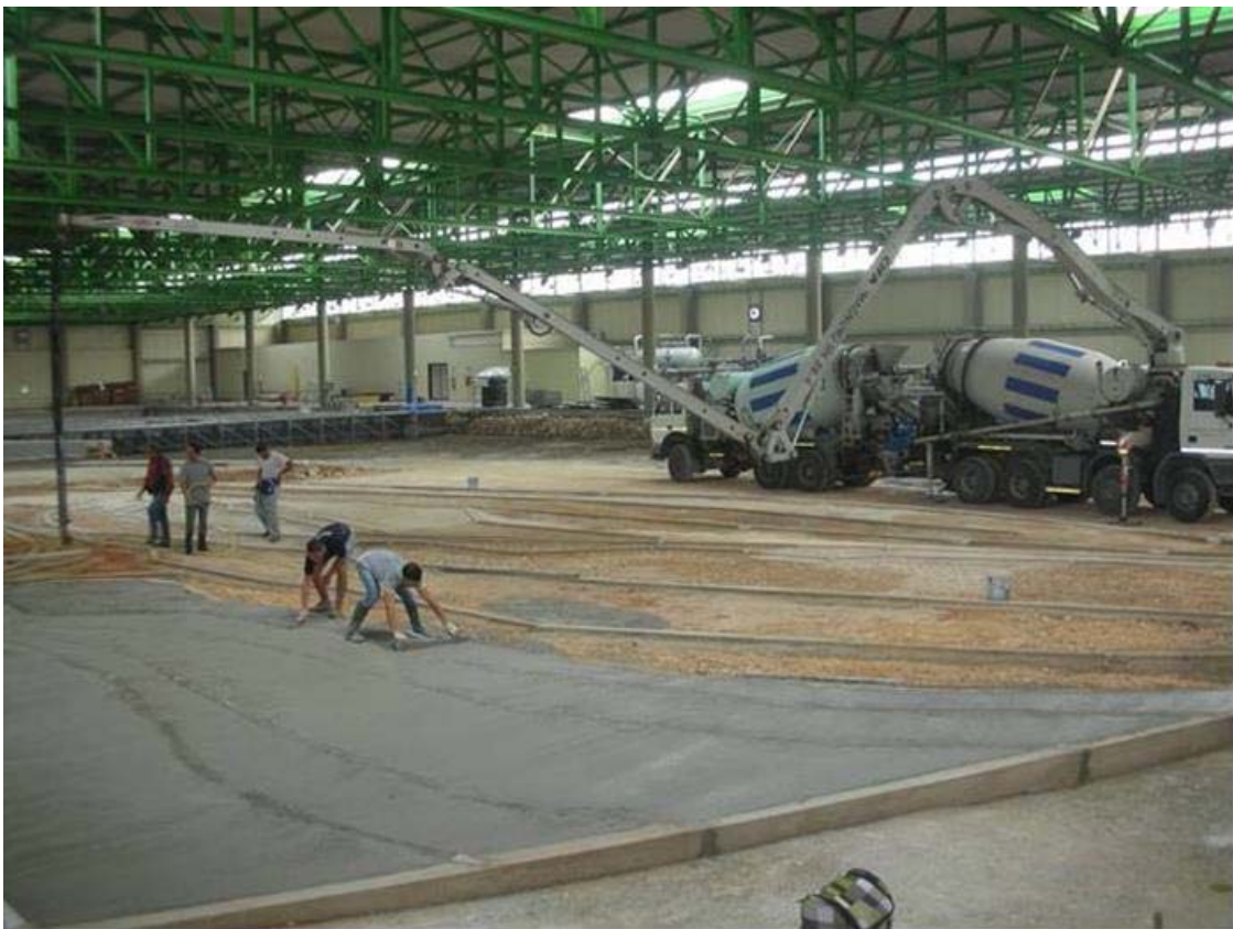
Fig. 2.11: Operazioni di getto di calcestruzzo.
