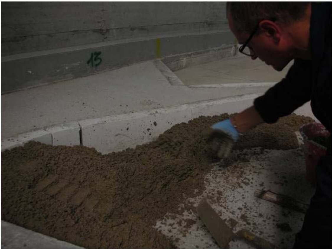
Fig. 2.23: Realizzazione della scogliera naturale. Un particolare della scogliera retrostante di una pocket beach
