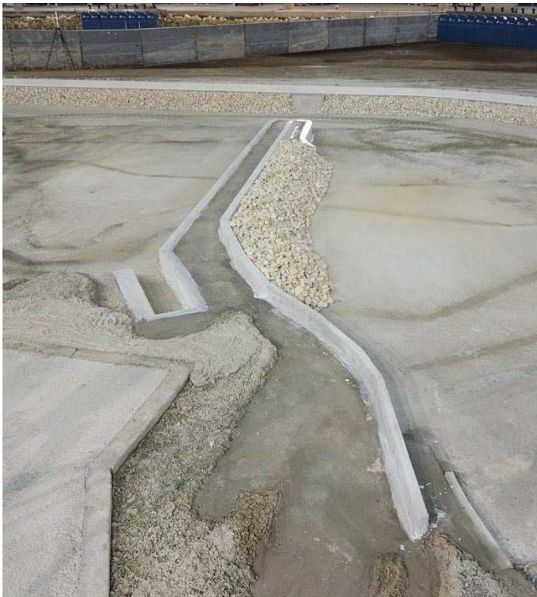
Fig. 6.3.1.12: completamento della superficie della banchina
