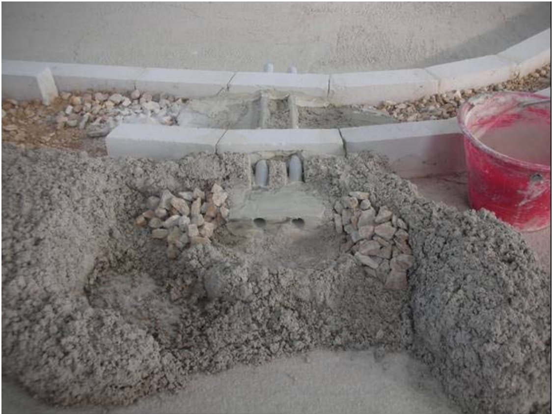
Fig. 2.35: Fase finale della posa dei condotti di ricircolo del porticciolo
