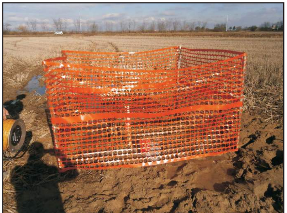
Foro attrezzato con piezometro
