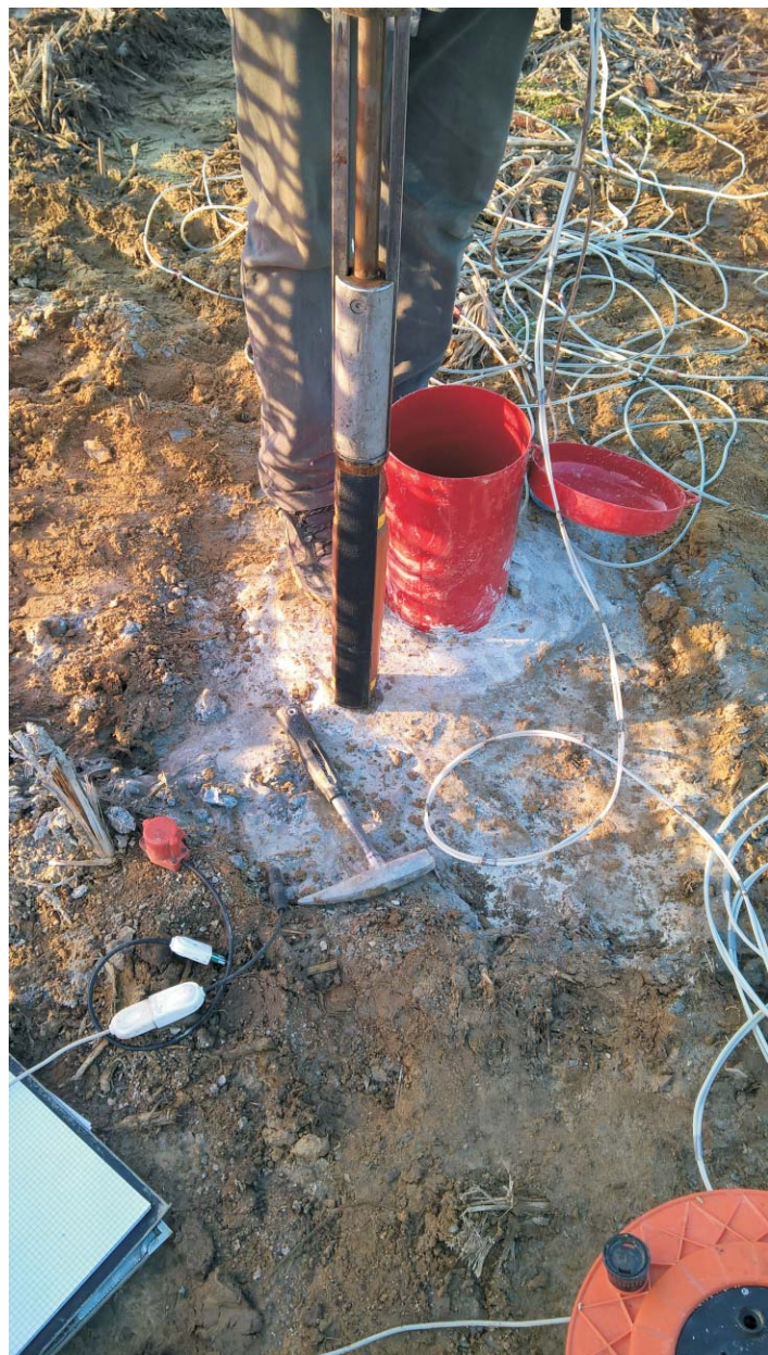
Foto n.4: Cross Hole 2, compressore ed energizzatore pronto ad essere calato per la battuta
