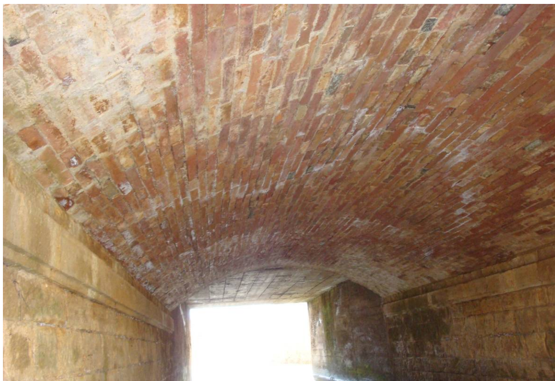
Foto 5 – Vista intradosso – volta in muratura
