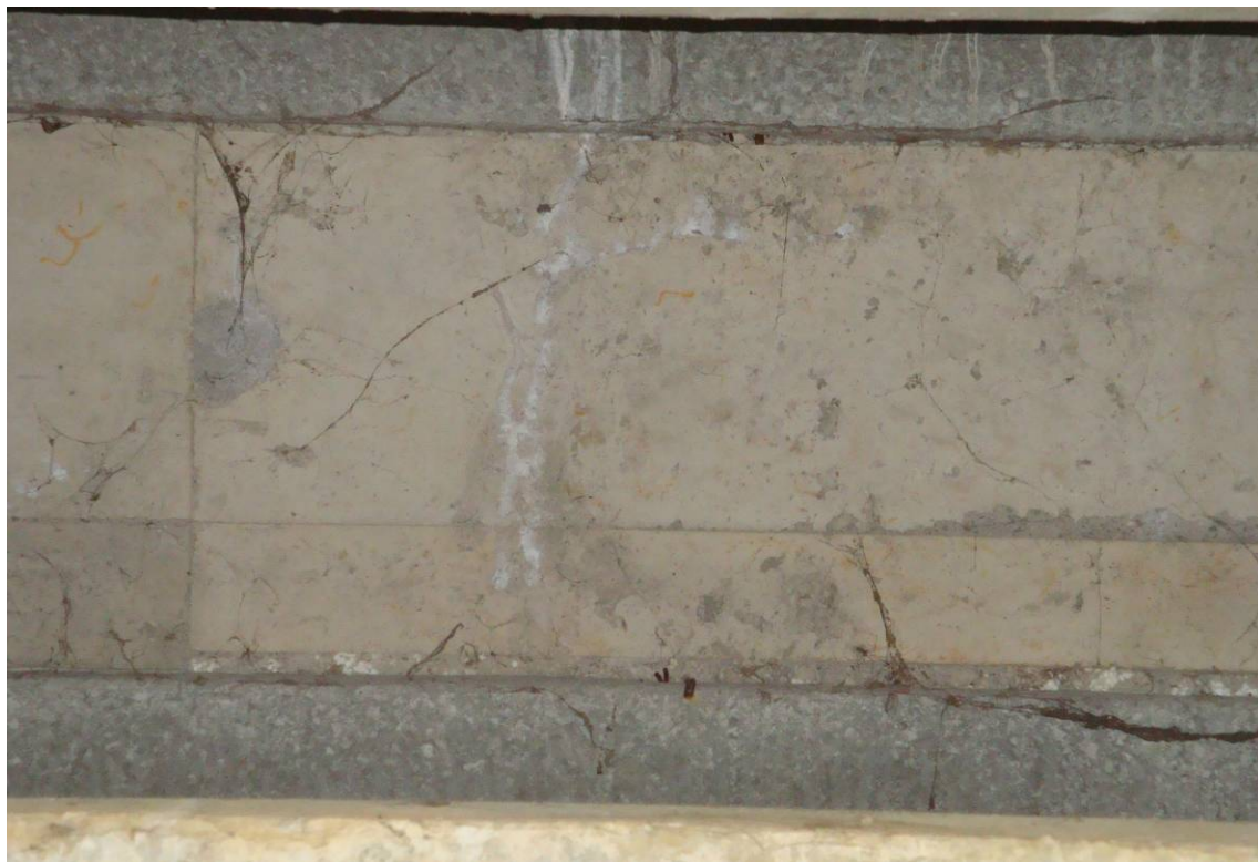
Foto 7 – Particolare intradosso soletta
