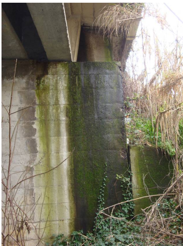
Foto 8 – Particolare spalla Grosseto
