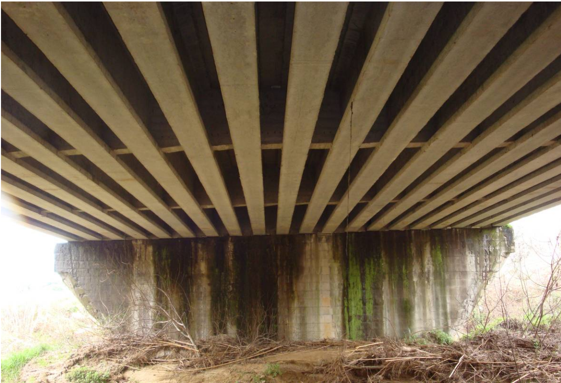
Foto 5 – Vista intradosso campata 2 – vista pila 2
