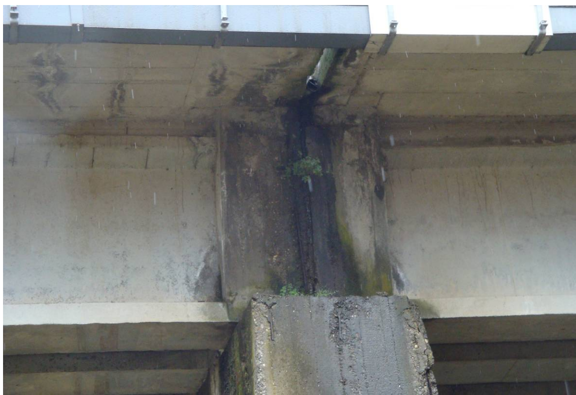
Foto 4 – Particolare appoggio su pila 2
