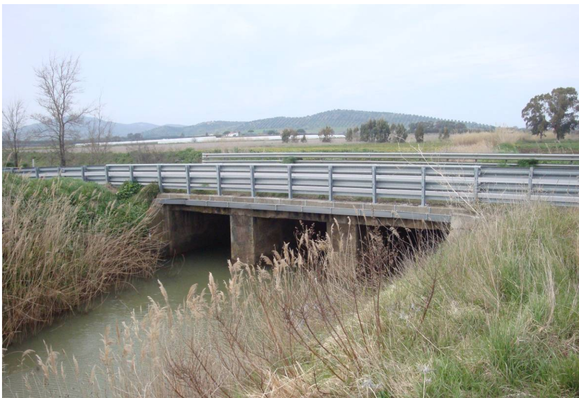
Foto 1 – Vista laterale – struttura in allargamento
