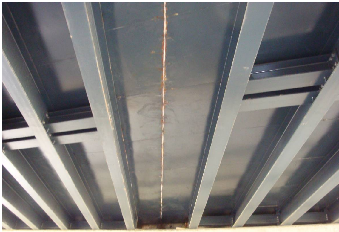
Foto 5 – Vista intradosso – giunto longitudinale tra i 2 impalcati
