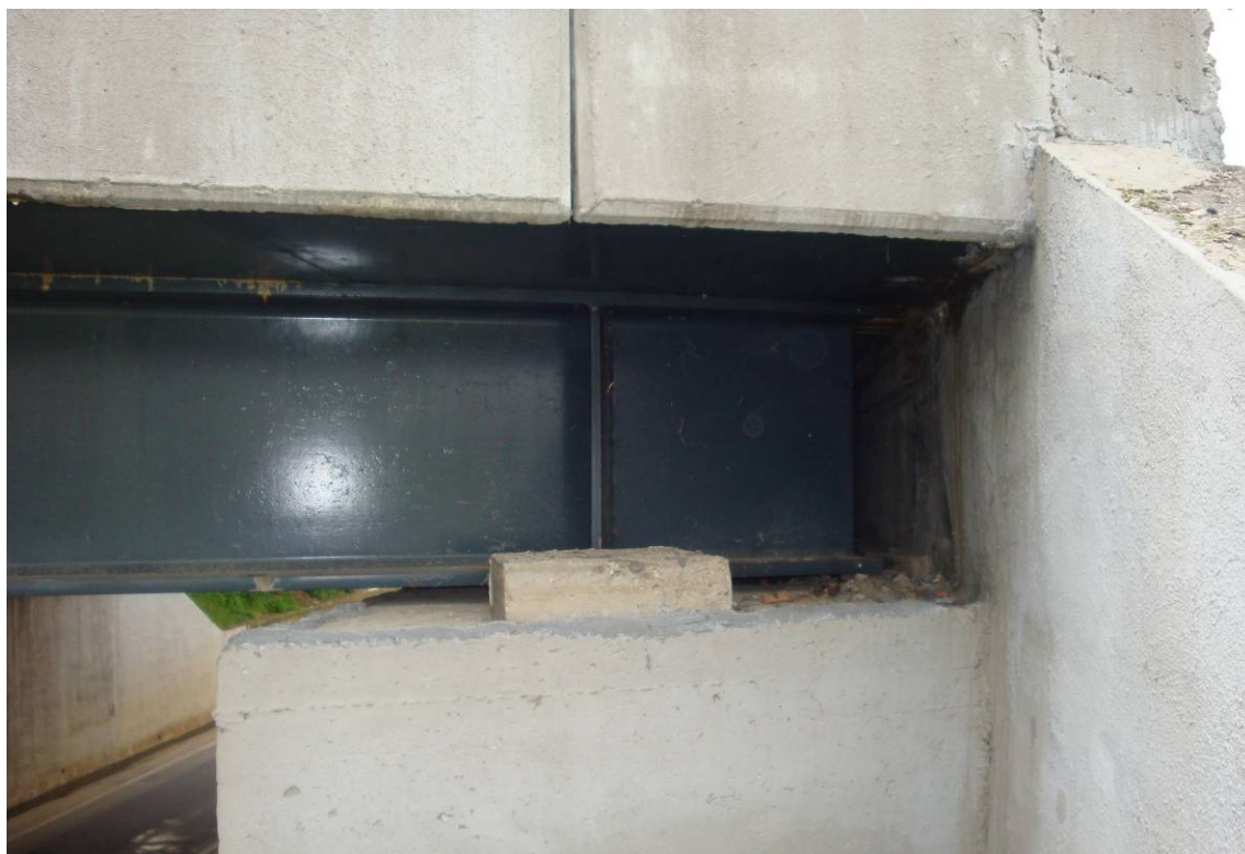
Foto 7 – Particolare zona di appoggio con ritegno sismico laterale
