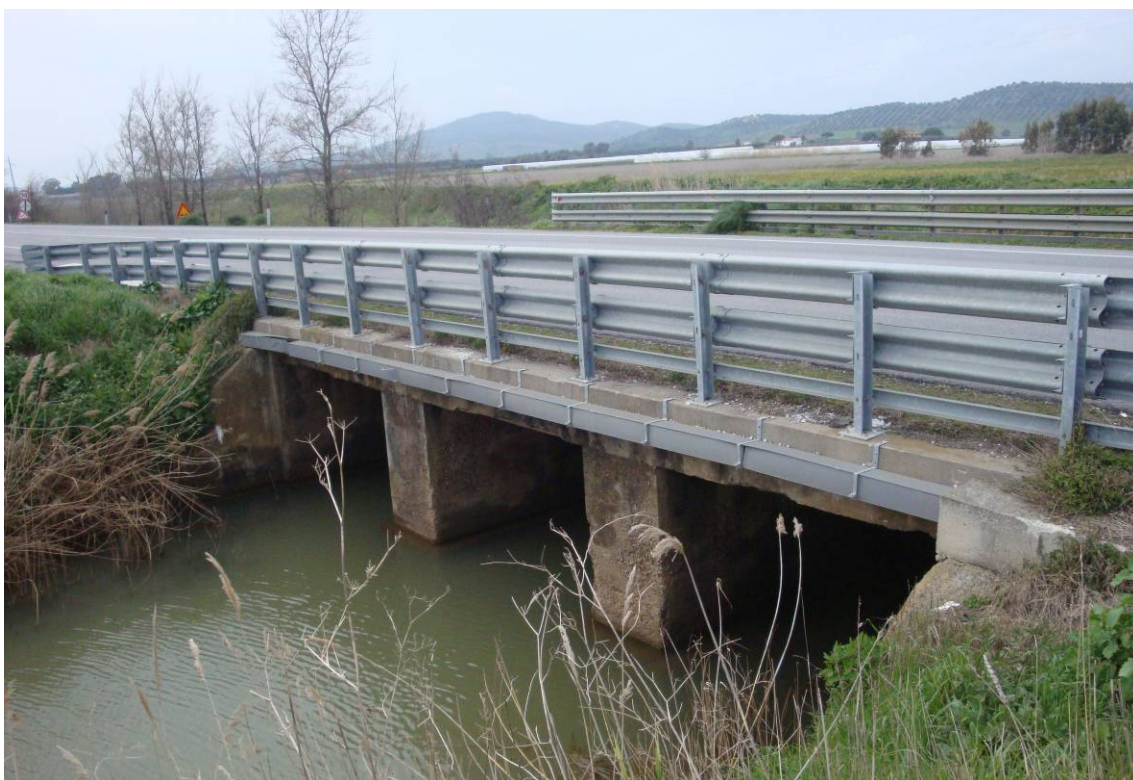
Foto 2 – Vista laterale – struttura in allargamento
