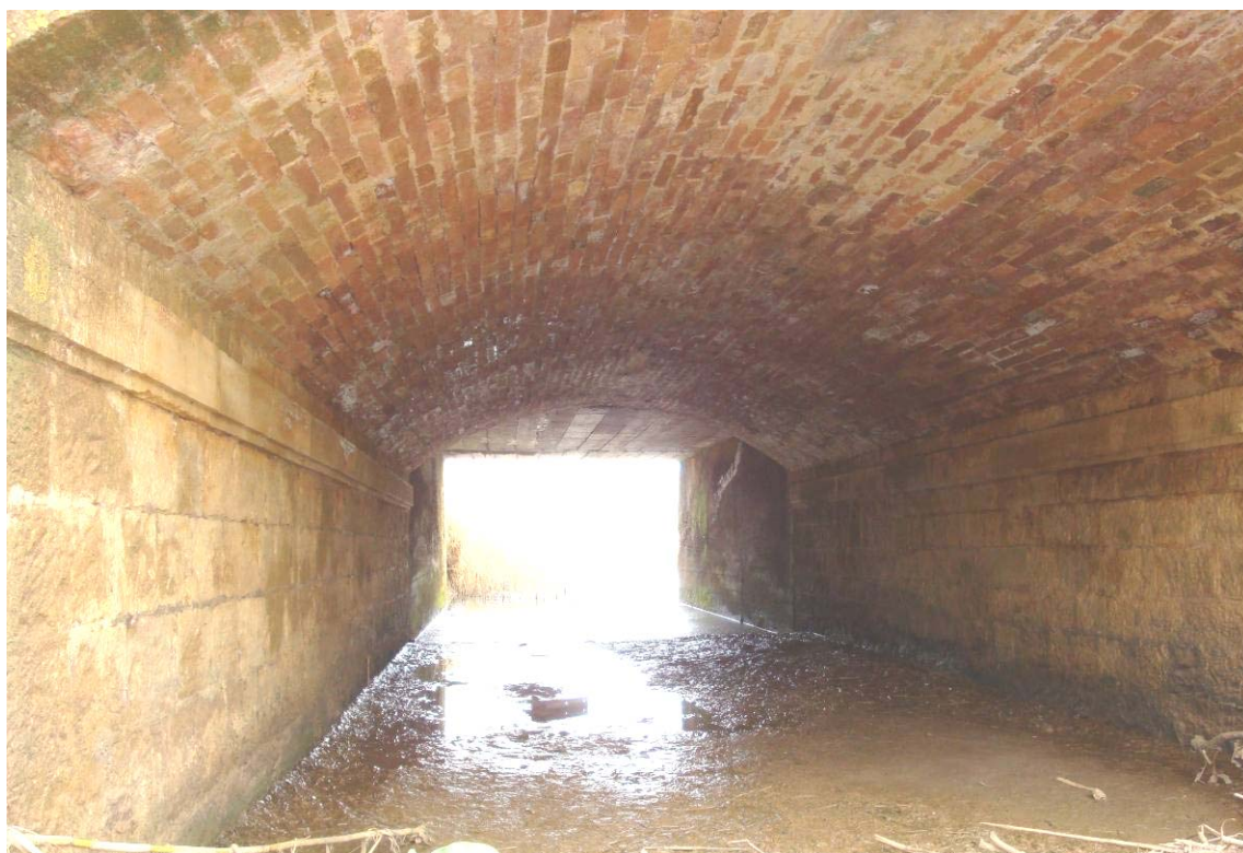
Foto 4 – Vista intradosso - volta in muratura
