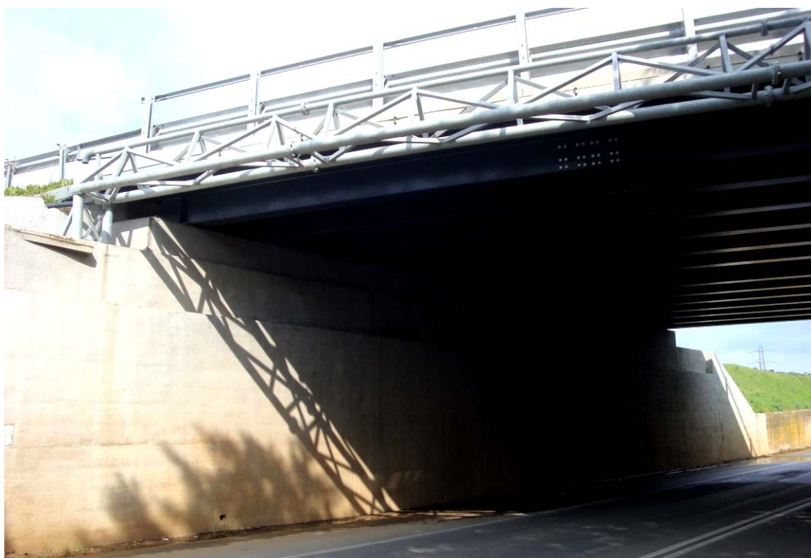
Foto 3 – Vista intradosso impalcato
