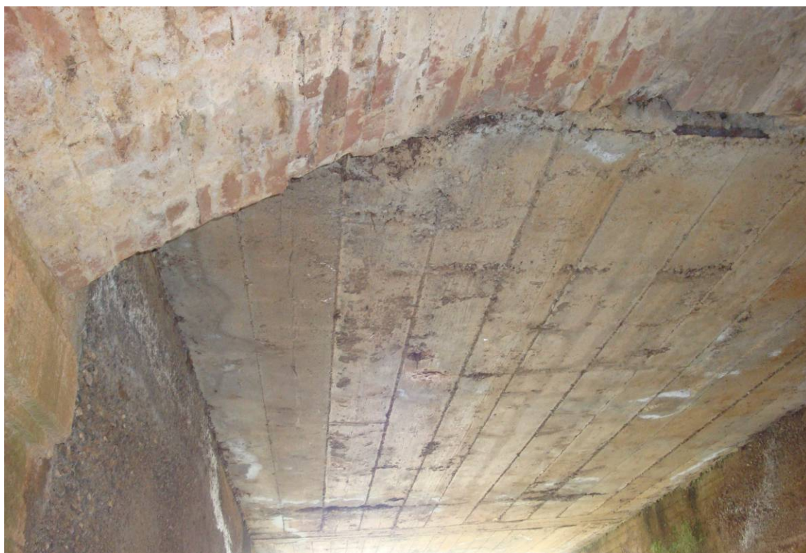
Foto 6 – Vista intradosso – solettone in c.a.
