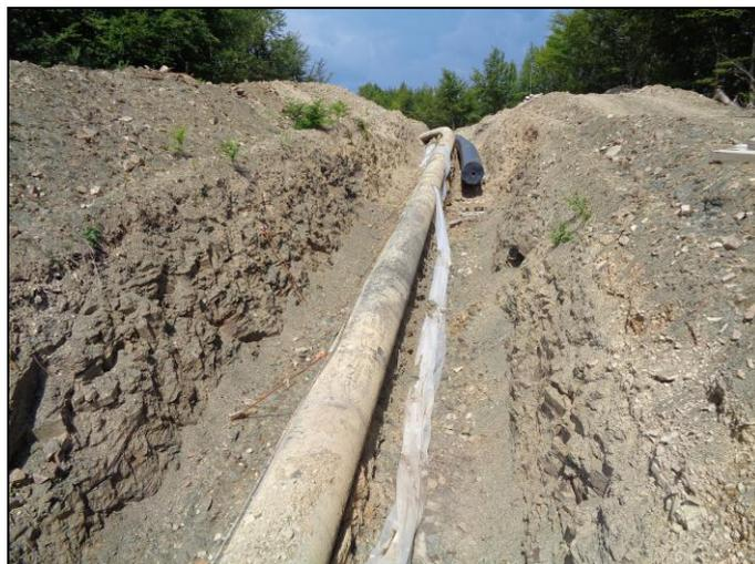
Figura 8 – Area di TIE-IN (a sx la condotta in dismissione - a dx la condotta in progetto)
