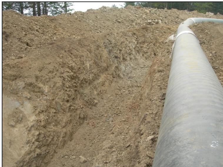
Figura 10 – Particolare dello scavo aperto per il metanodotto in costruzione (foto antecedente la posa della condotta)
