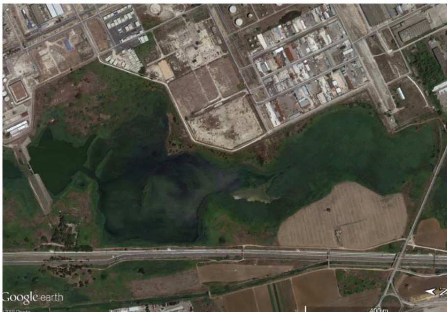
figura 3.6 - Serbatoio di regolazione e di decantazione (fonte: Google Earth)
