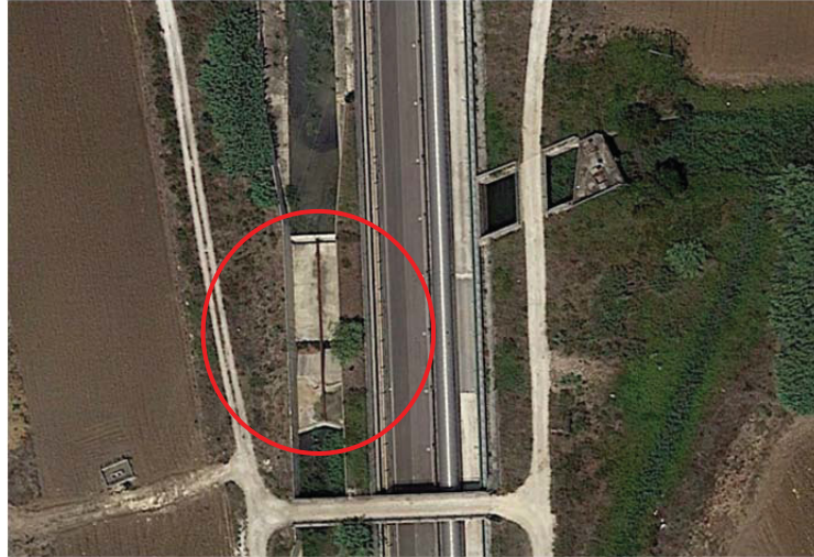
figura 3.5 - Opera di presa (fonte: Google Earth)
