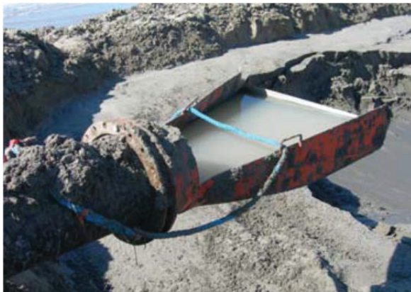
Figura 3.1-4 Refluimento in cassa di colmata
