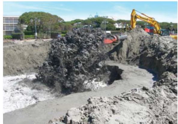
Figura 3.1-4 Refluimento in cassa di colmata
