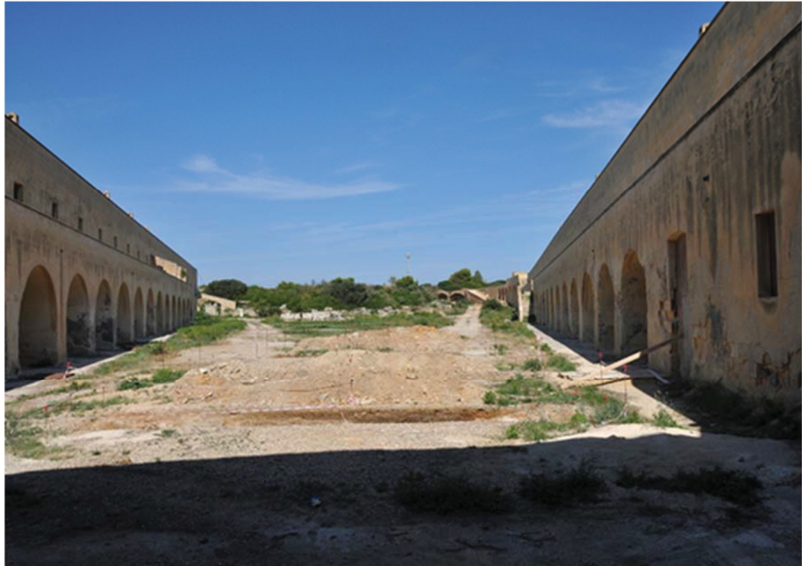
Figura 1-8. Ripresa fotografica del Forte
