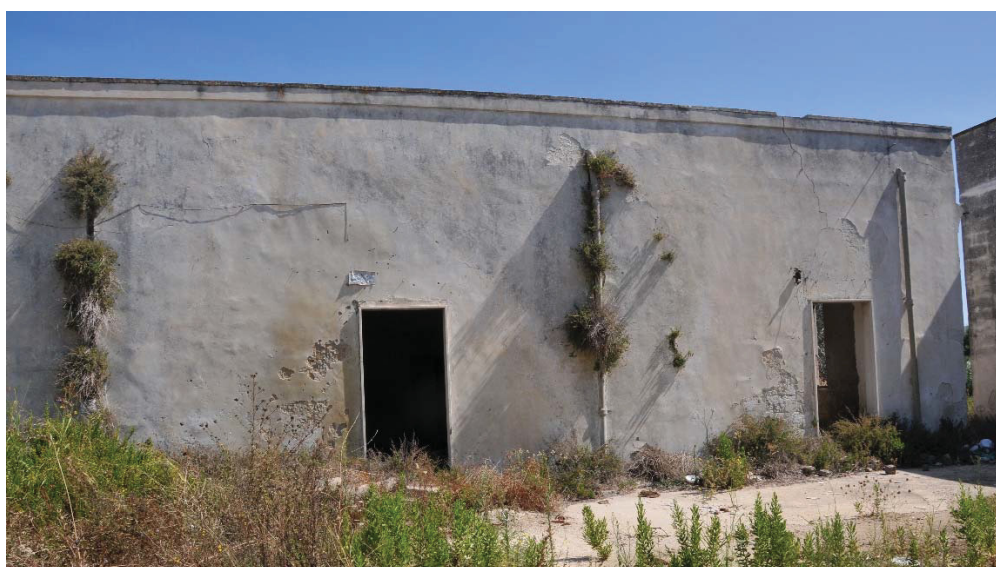
Figura 1-21. Masseria Frassino, ingressi dal cortile ai locali al piano terra.
