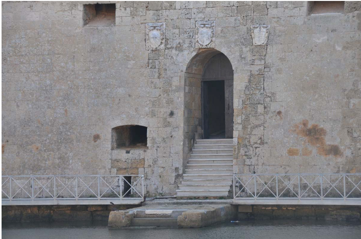
Figura 1-7. Ripresa fotografica dell'accesso al castello dalla darsena quadrangolare
