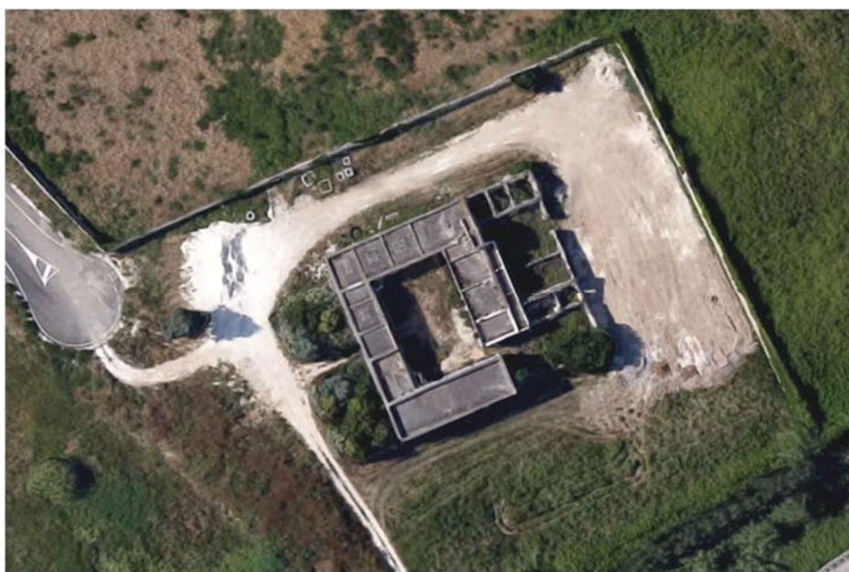
Figura 1-18. Masseria Frassino, vista aerea
