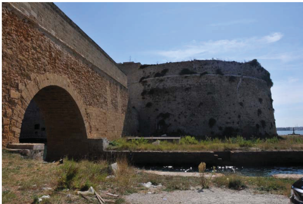
Figura 1-5. Ripresa fotografica del Torrione circolare e dell'accesso alla darsena quadrangolare
