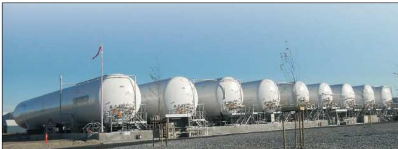
Figura 16: Esempio di serbatoi criogenici (impianto GNL a Fredrikstad – Norvegia)
