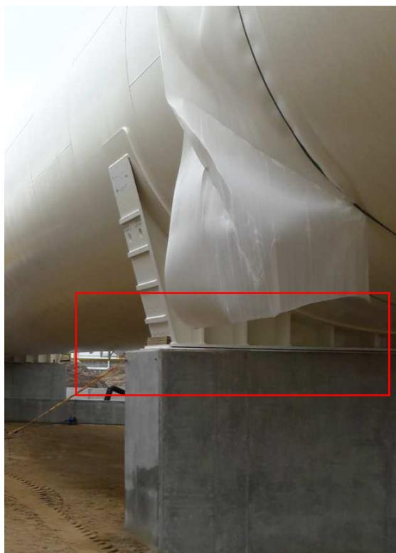
Figura 18: Esempio piastra di scorrimento per dilatazione
