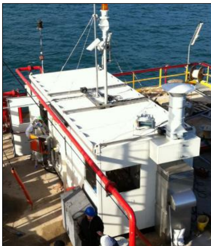
Figura 10: Esempio Control room banchina con anemometro
