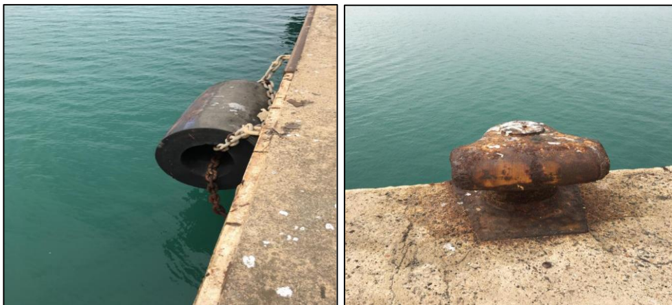
Figura 30: Fender e bitte presenti nella banchina del Porto Canale
