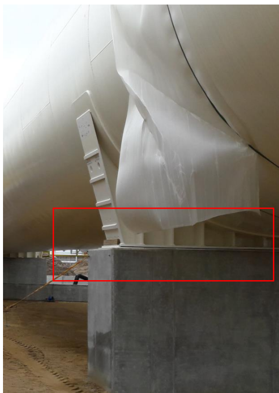
Figura 18: Esempio piastra di scorrimento per dilatazione
