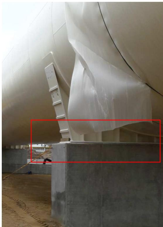
Figura 14: Esempio piastra di scorrimento per dilatazione
