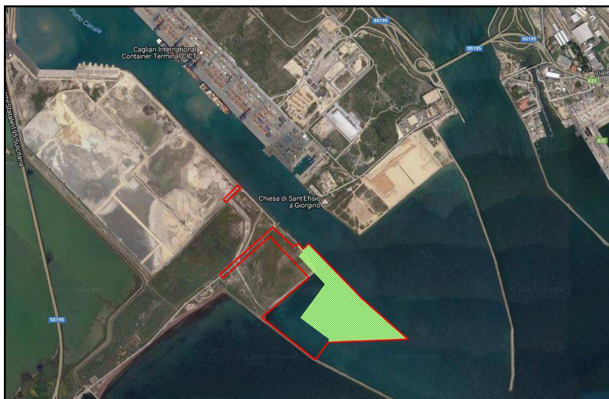
Figura 56 – Ubicazione dell'area di intervento (Fonte: S.I.A. – Porto Canale di Cagliari – Terminal Ro-Ro – I° lotto funzionale VDP s.r.l. - Autorità Portuale).
