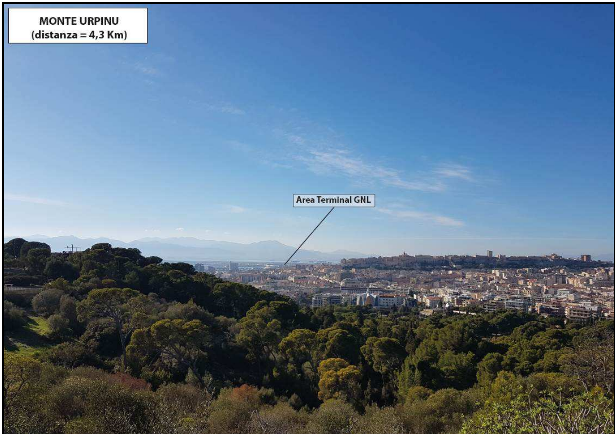
Figura 47 - Sky-line dal punto panoramico del Colle di Monte Urpinu e ubicazione del Terminal GNL in progetto.
