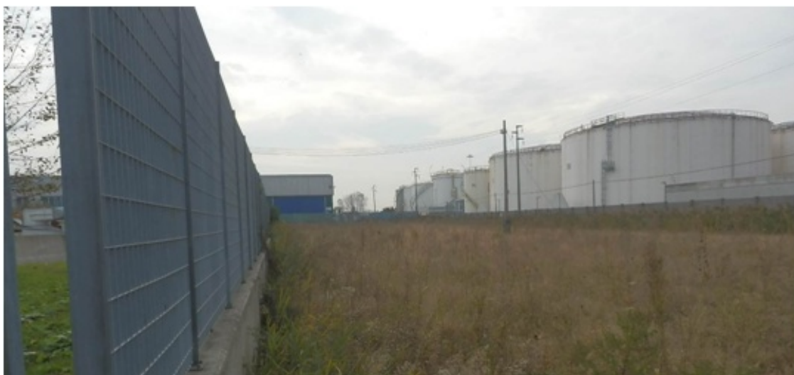
Figura 6.c: Vista verso Sud dell'Area di Interesse con Serbatoi DECAL sullo Sfondo
