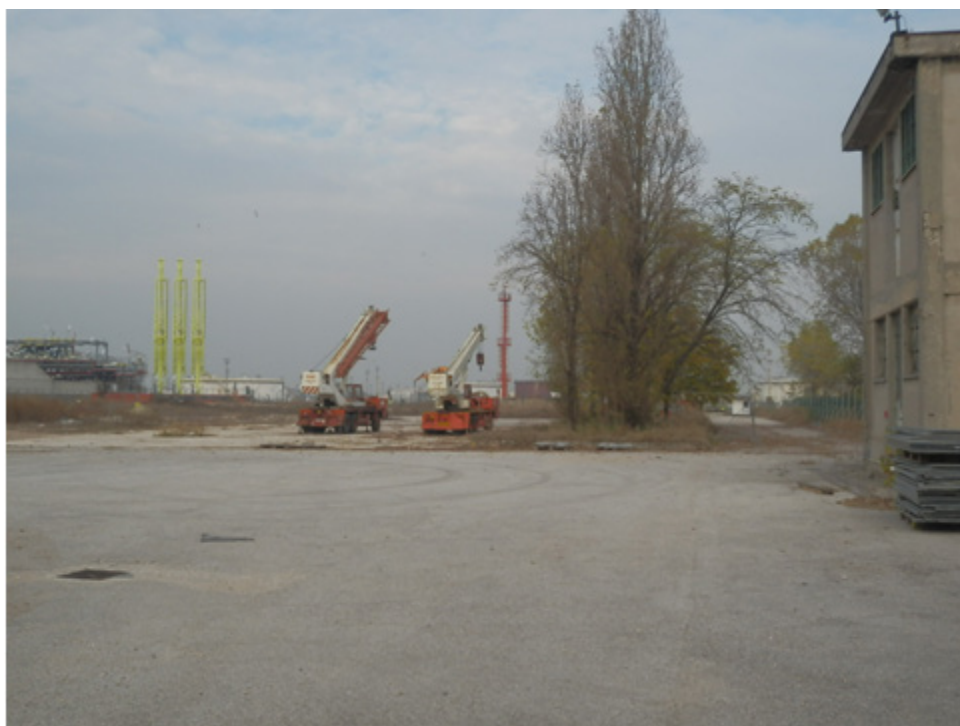
Figura 6.e: Vista verso Nord dell'Area di Interesse
