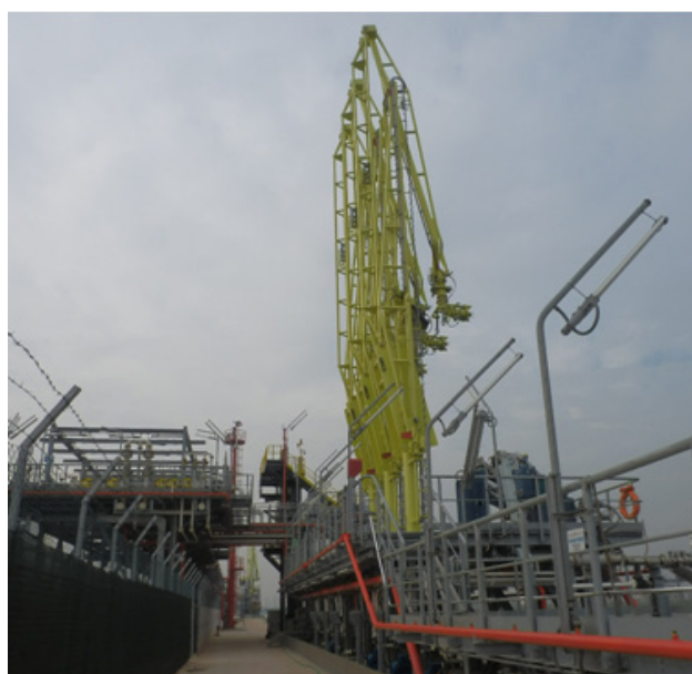
Figura 6.d: Bracci di Carico lungo la Banchina DECAL in prossimità dell'Area di Interesse
