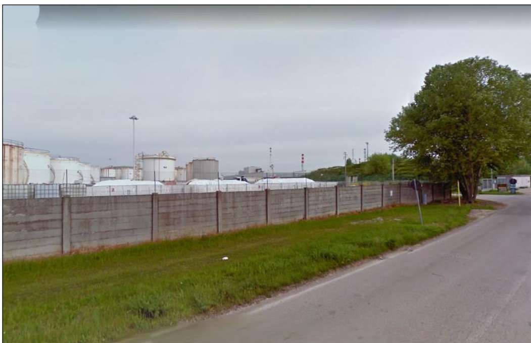
Figura 53. Area di impianto della torcia di sicurezza e dei serbatoi d'acqua anti incendio
