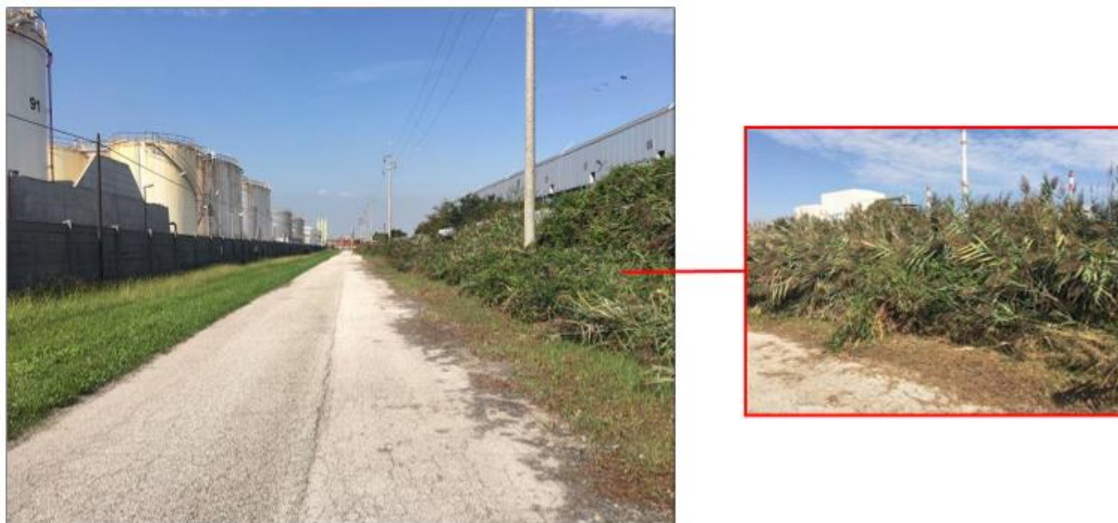
Figura 51. La strada asfaltata di accesso all'area
