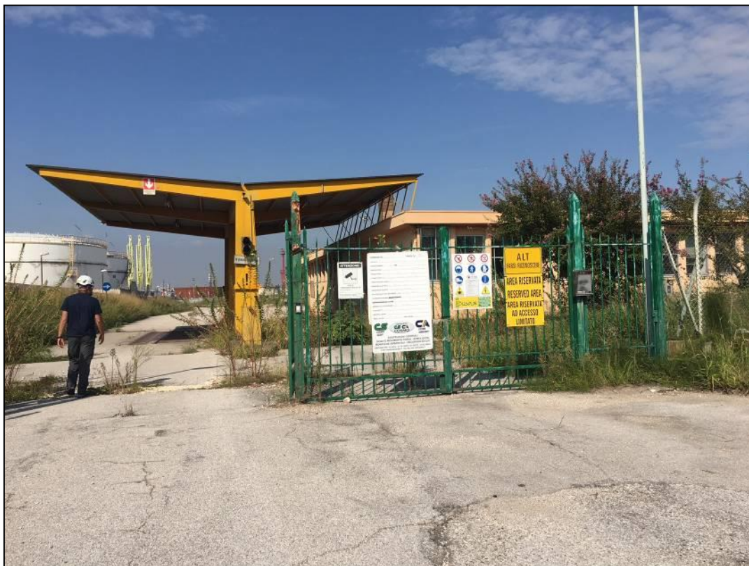
Figura 52. Accesso all'area di cantiere
