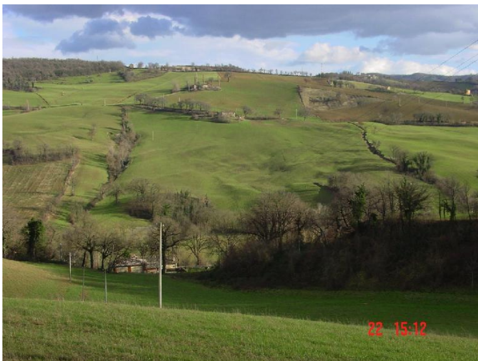
Figura 3.3: grande area di dissesto a Sud di Camerino (lotto 4).
