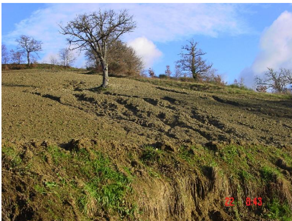
Figura 3.4: fenomeni di erosione superficiale dovuta a forti precipitazioni nel periodo invernale.
