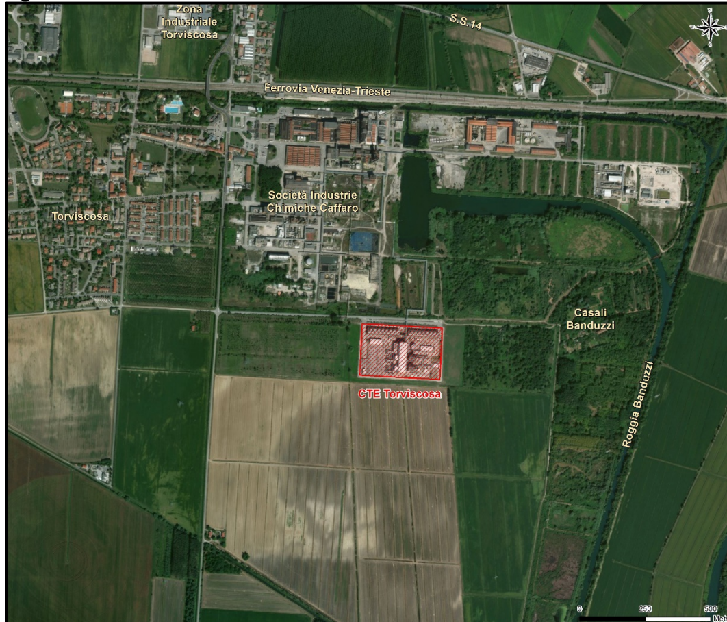
Figura 3.1a Localizzazione della Centrale Termoelettrica di Torviscosa
