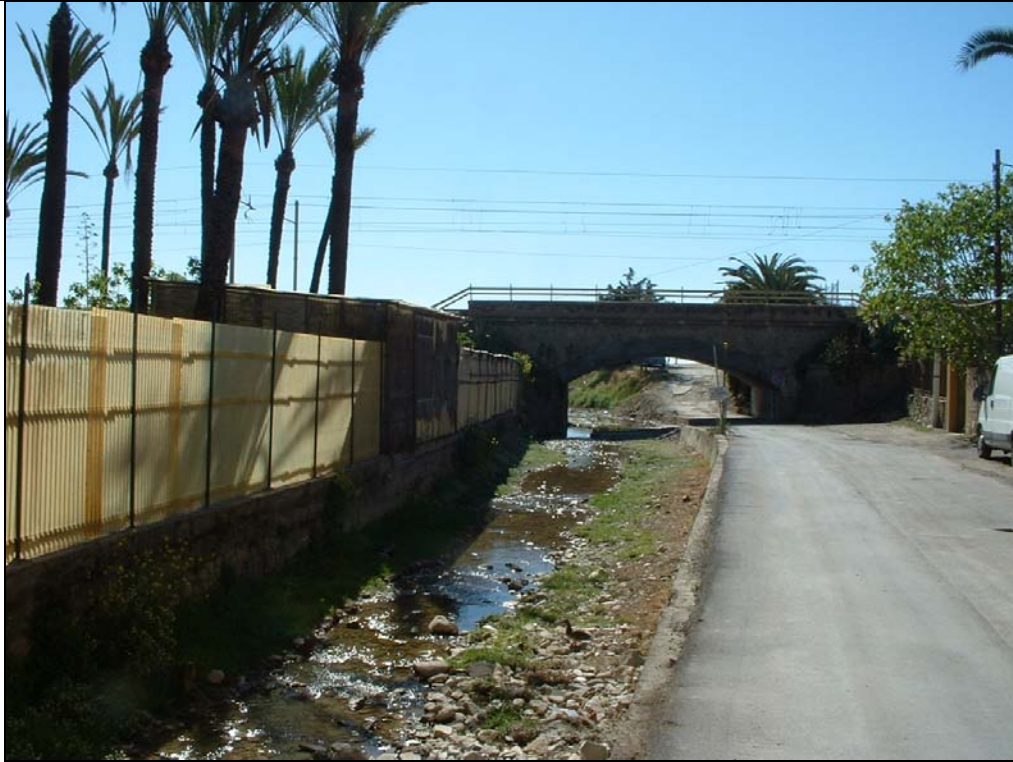
FOTO N° 3 Vista da monte del ponte della ferrovia.
