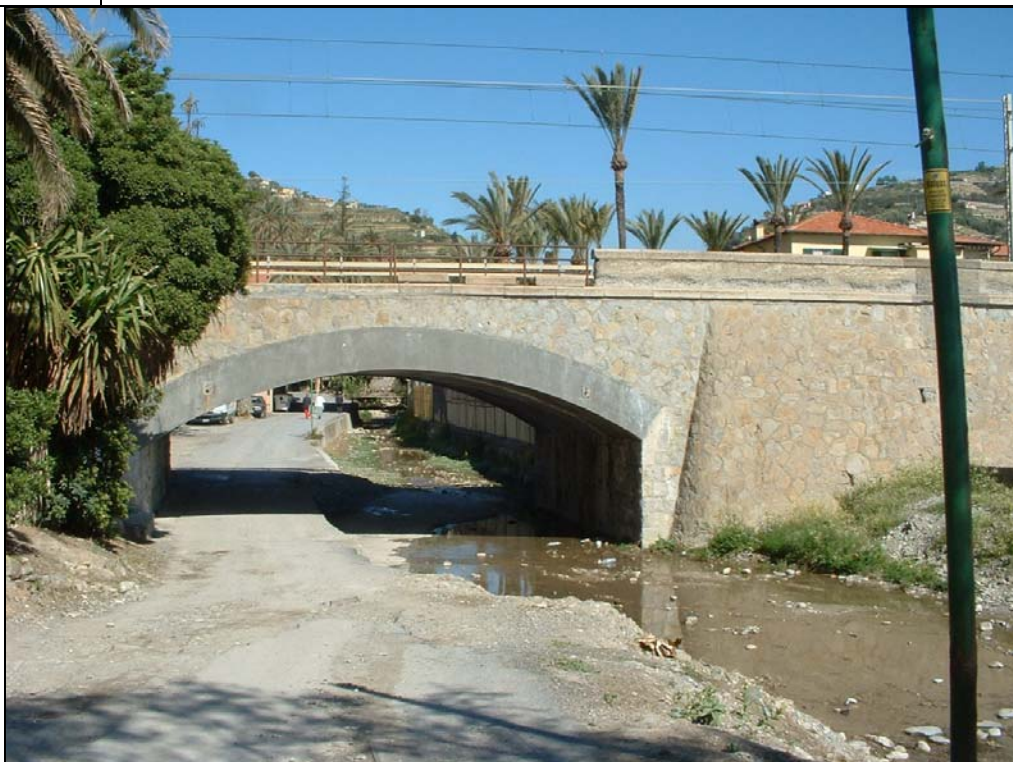
FOTO N° 4 Vista da valle del ponte della ferrovia.
