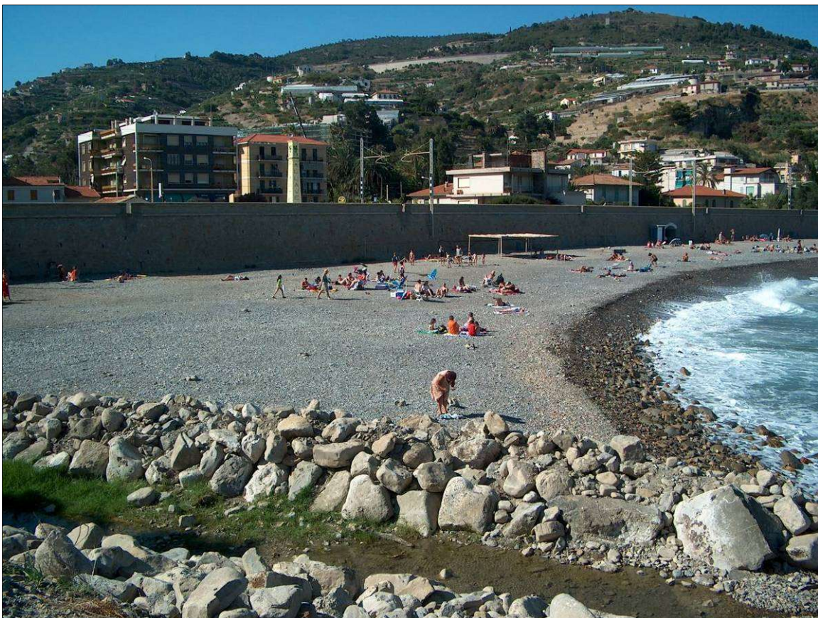
foto 2: Il rilevato ferroviario risulta in più che discrete condizioni di stabilità e si erge al di sopra del fondovalle pianeggiante.
