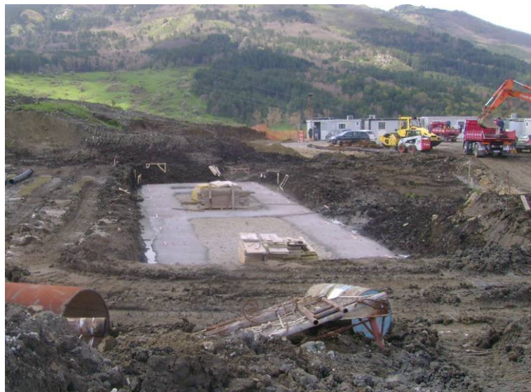
Figura 15 fondazione e realizzazione edificio utente entro area sottostazione.
