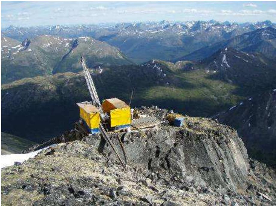
**Foto 12:** Esempio di cantiere in ambiente montano, analogo a quello previsto, con sonda DB LF70
