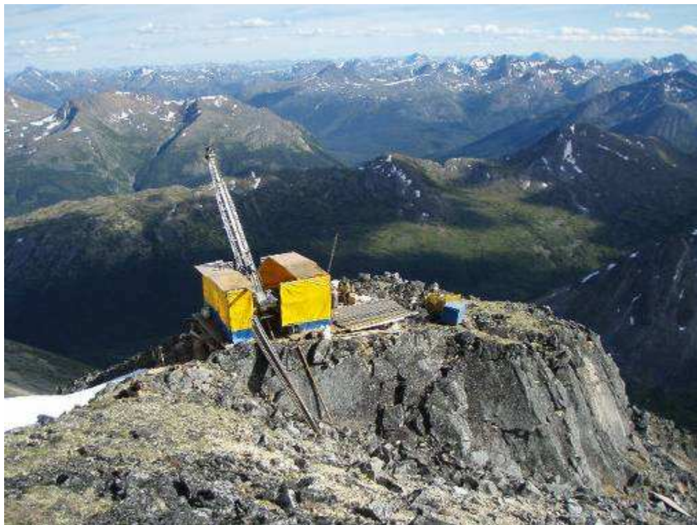
Foto 5: Esempio di cantiere in ambiente montano, analogo a quello previsto, con sonda DB LF70
