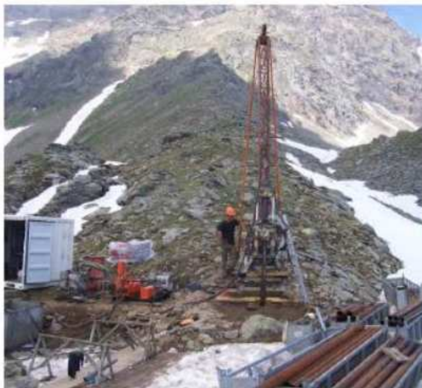
Foto 6: Sonda Longyear 34 per carotaggio in ambiente montano.
