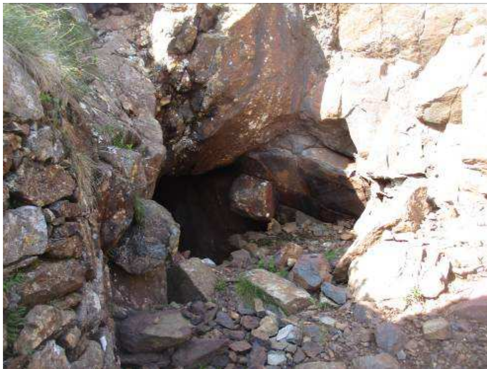
Foto 13: Vecchio imbocco minerario ubicato internamente ai confini della ZPS "Alta Val Strona e Val Segnara").
