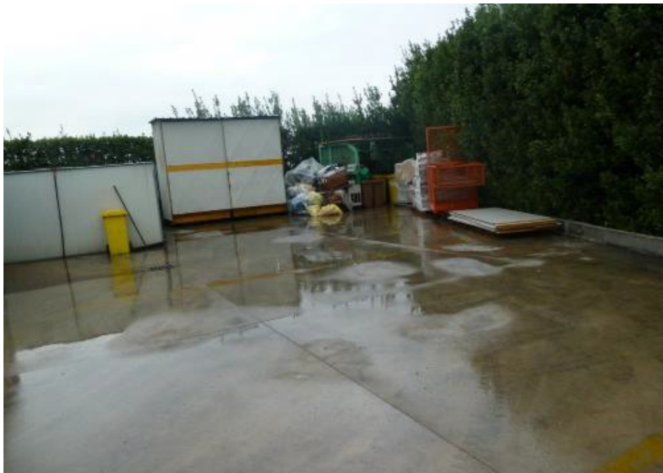
Foto 4 - Particolare del sito: area nordovest.
