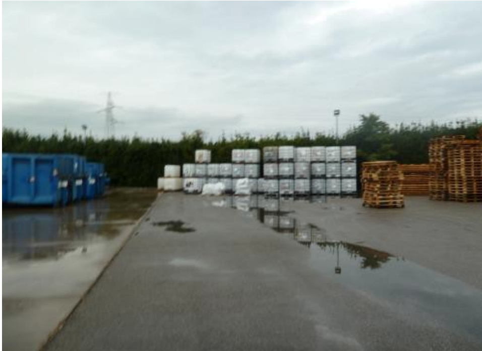
Foto 1 - Panoramica del sito, vista nord.
