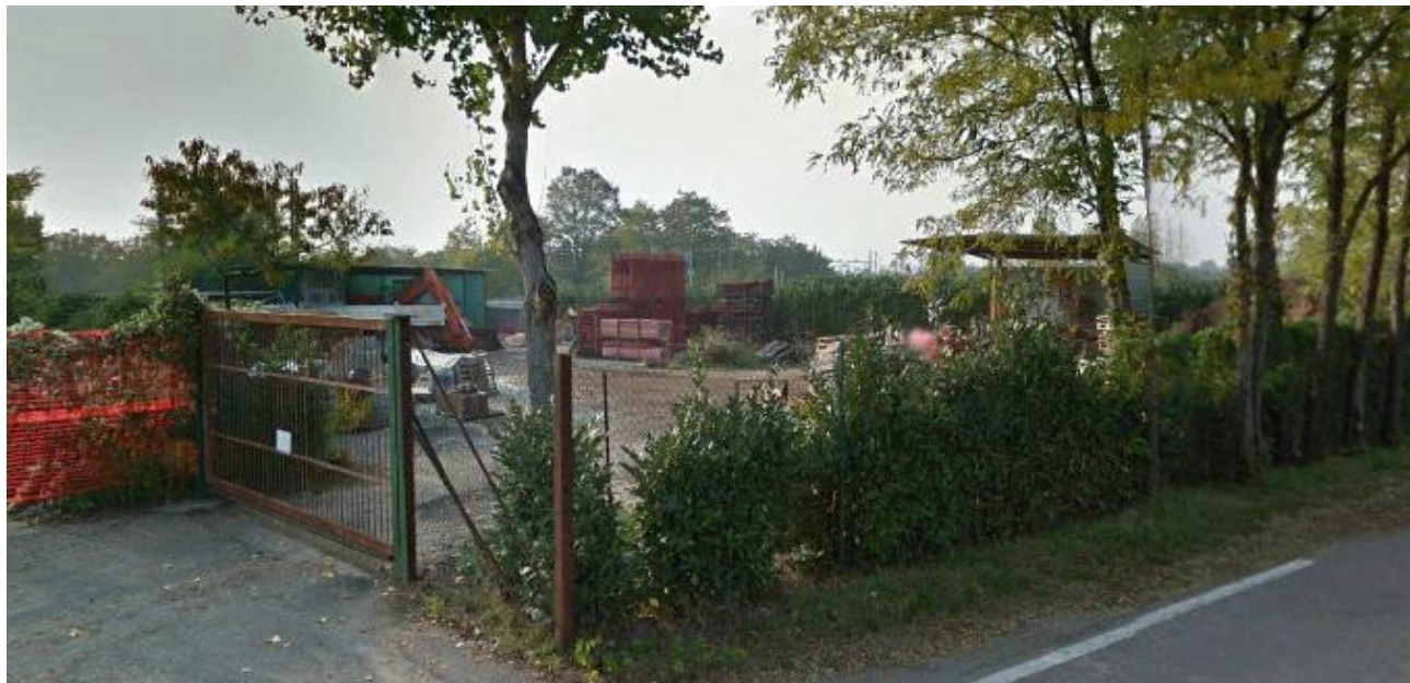
Foto 1 - Panoramica del sito, vista nordest.
