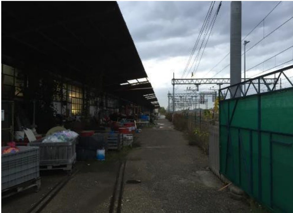
Foto 2 - Vista dell'area esterna nord.
