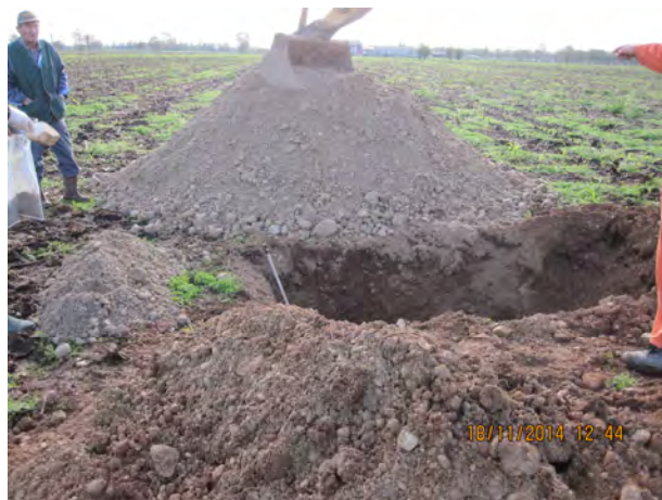
Scavo trincea 12TRe (da m 0,00 a m 1,00)
