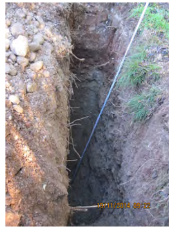
Scavo trincea 09TRe (da m 0,00 a m 3,50)
