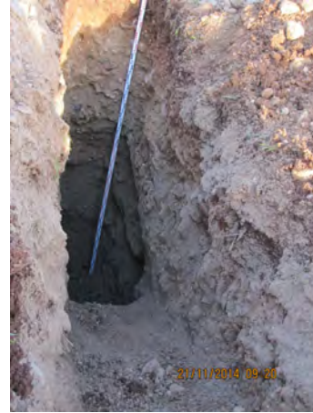
Scavo trincea 19TRe (da m 0,00 a m 3,50)
