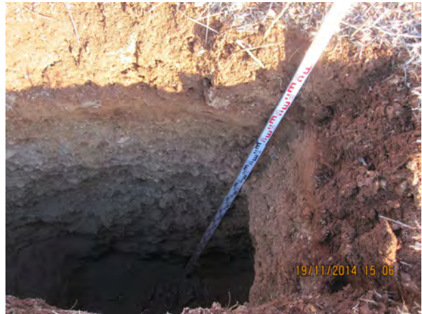
Scavo trincea 06TRe (da m 0,00 a m 3,50)
