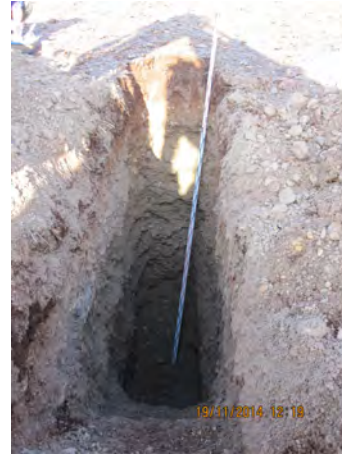
Scavo trincea 02TRe (da m 0,00 a m 3,50)
