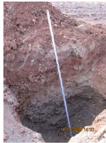
Scavo trincea 07TRe (da m 0,00 a m 3,50)
