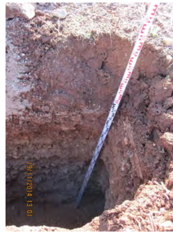
Scavo trincea 03TRe (da m 0,00 a m 3,50)
