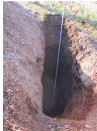
Scavo trincea 08TRe (da m 0,00 a m 3,50)
