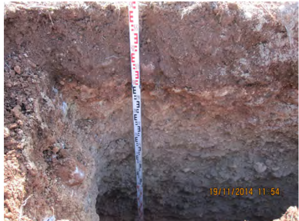
Scavo trincea 01TRe (da m 0,00 a m 3,50)
