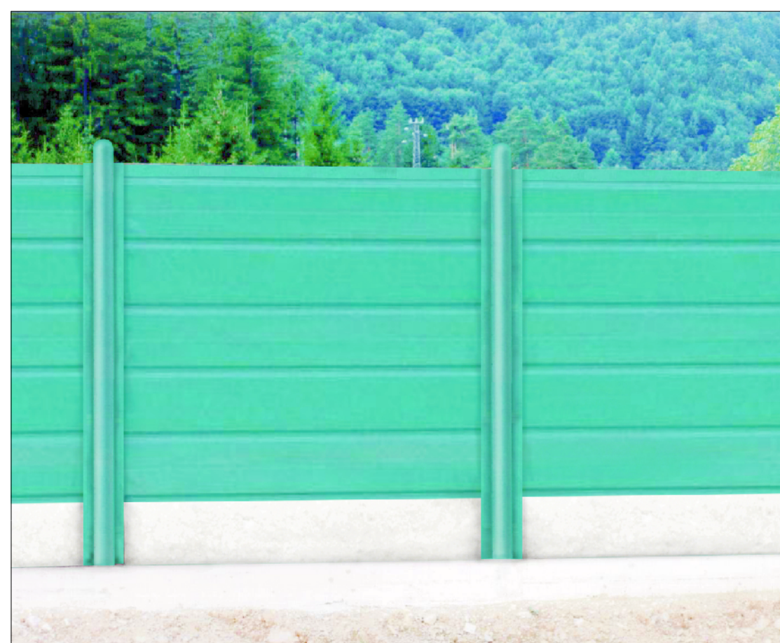
Foto - prospetto barriera (lato strada)
