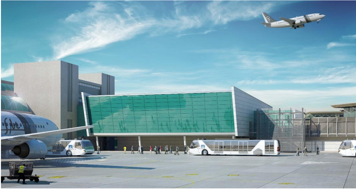
Vista esterna della testata Ovest del NID
